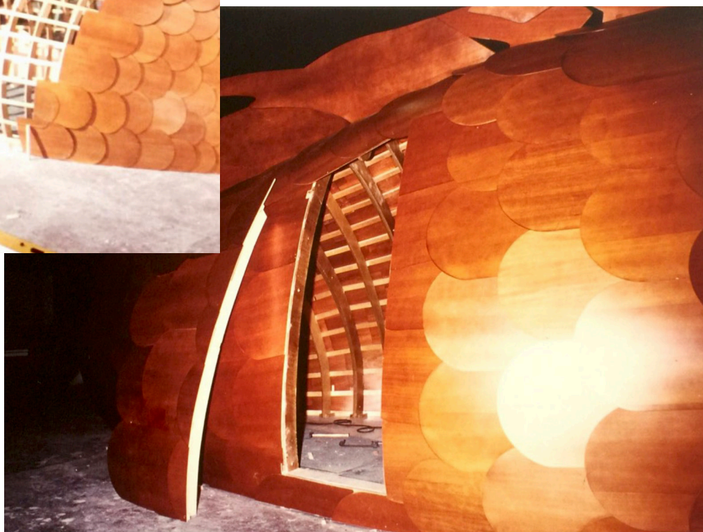
Figg. 51, 52 - Fotografie della Casa Pesce in costruzione negli stabilimenti GFT di Torino, Archivio GFT.
