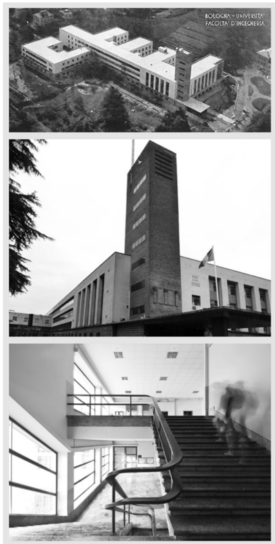
Fig.74 - Scuola di Ingegneria e Architettura di Bologna.
