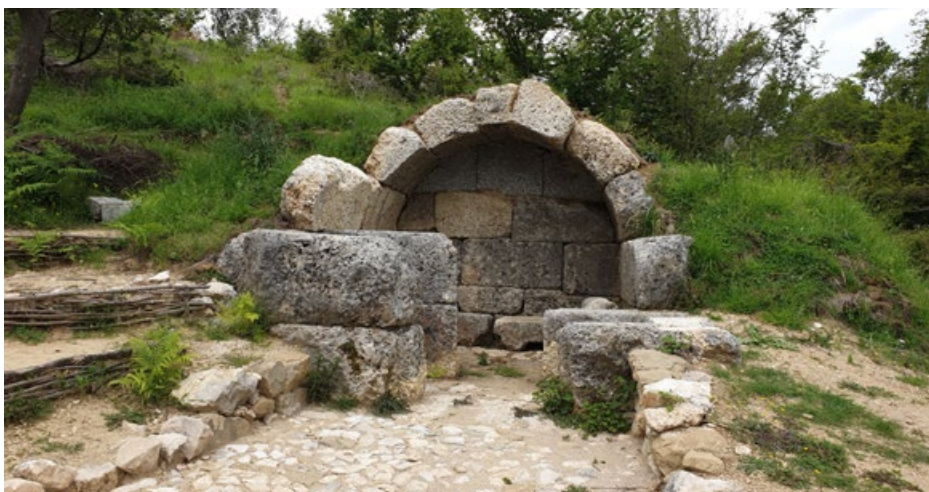
Fig. 24: La tomba monumentale dopo il restauro del 2019
