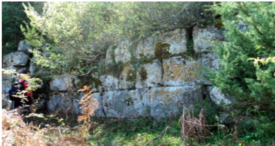
Fig. 23: Il bastione orientale di Persqop
