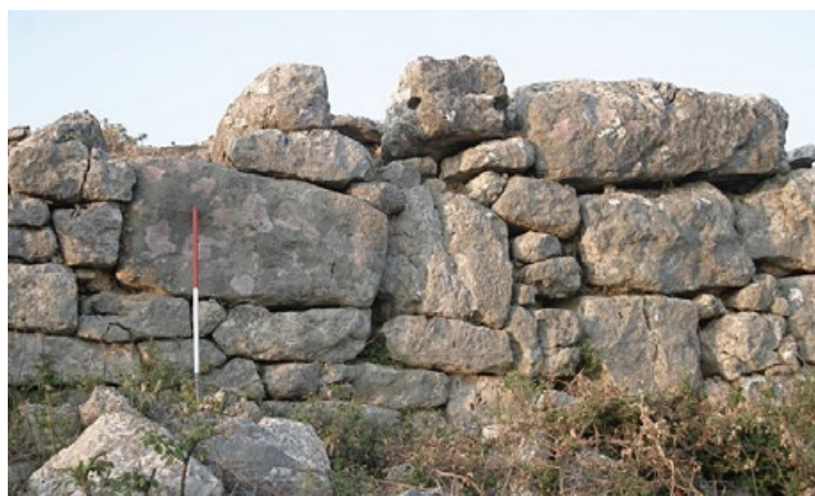
Fig. 17: Frammento di cinta muraria della prima fase
