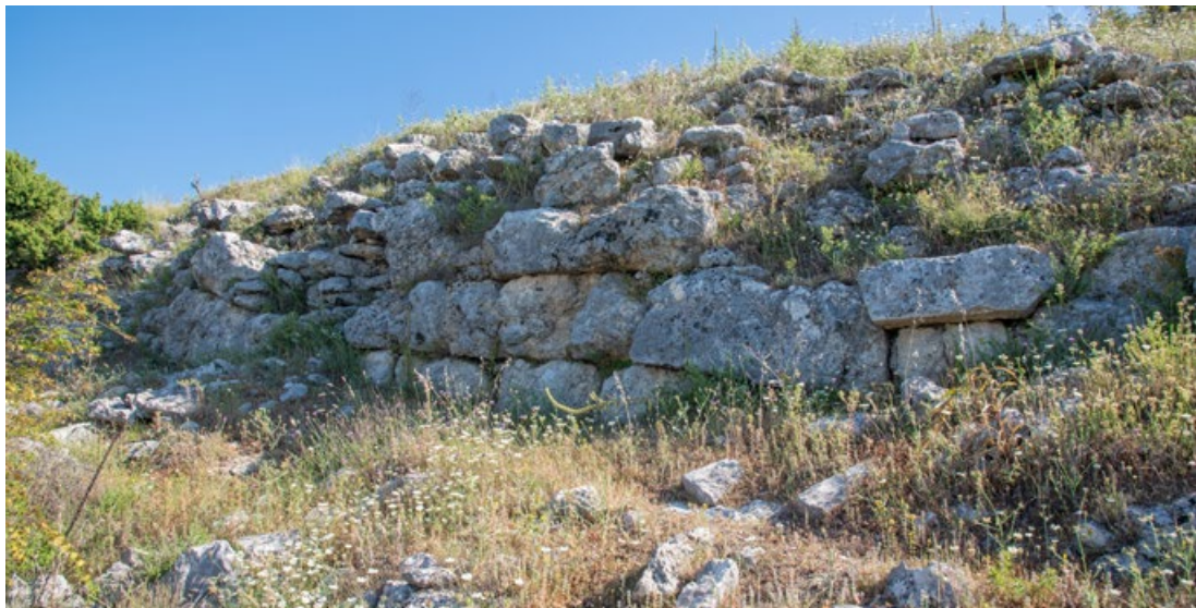
Fig. 67, 68: Frammento della seconda fase costruttiva della fortificazione di Dorëz
