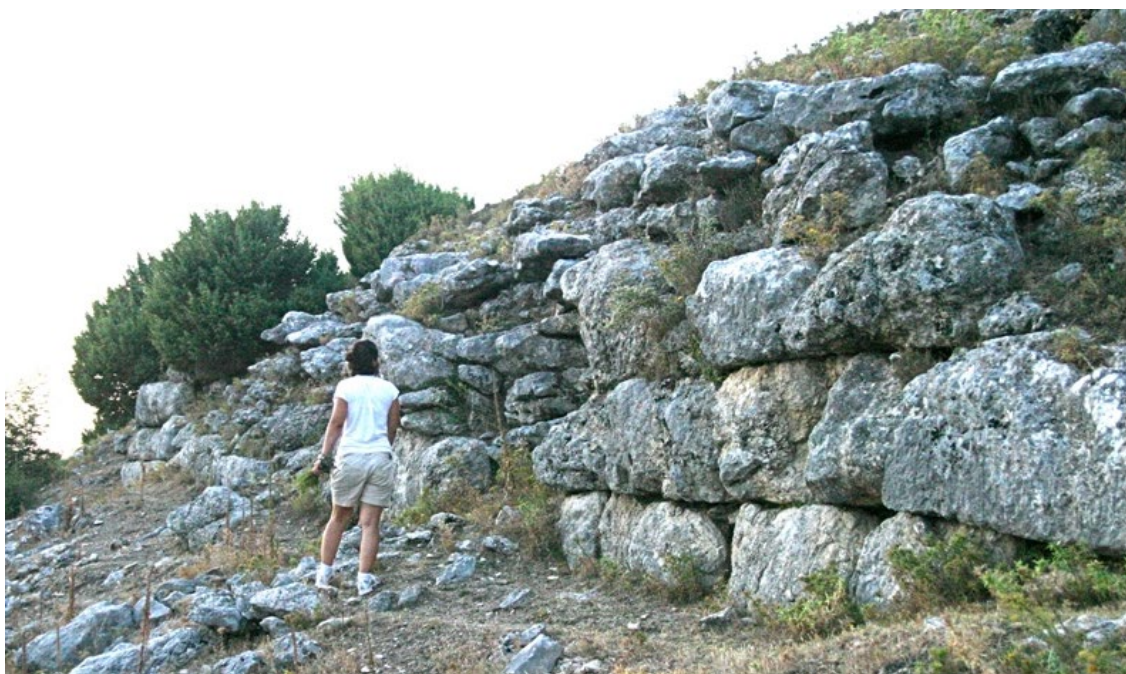
Fig. 66: Frammento della seconda fase costruttiva della fortificazione di Doröz
