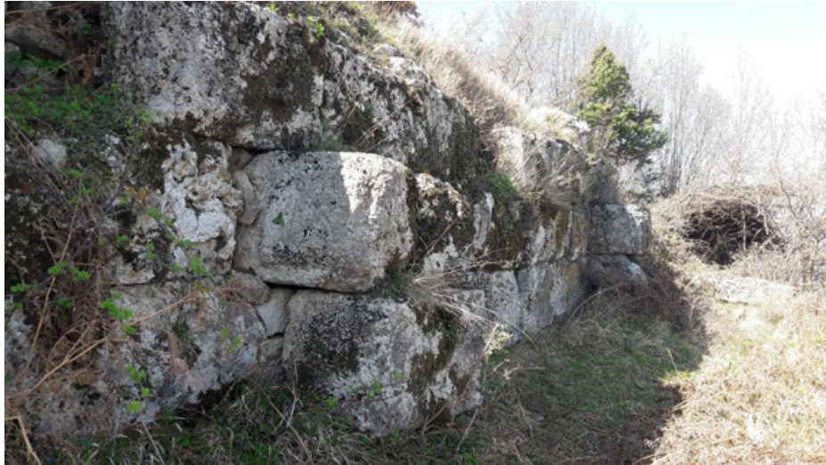
Fig. 89: Tratto delle mura del bastione orientale di Persqop (indicato nella planimetria del sito con lettera A)
