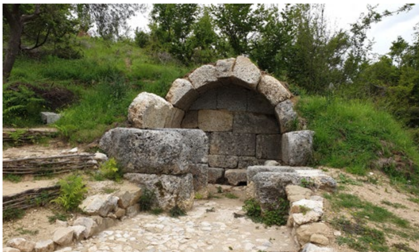
Fig. 96: La tomba monumentale di Persqop dopo il restauro del 2018
