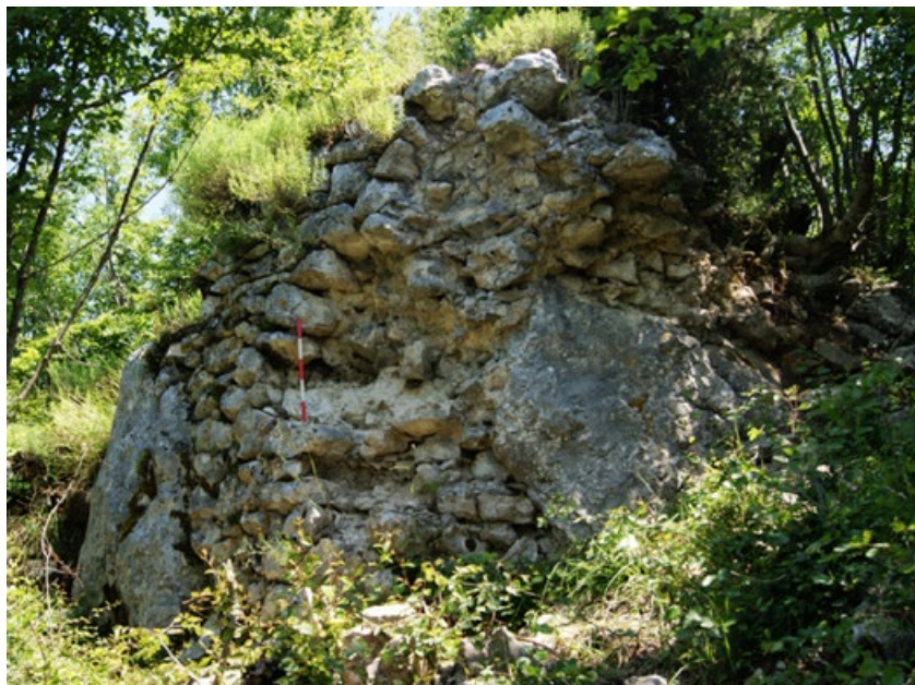
Fig. 33: Parte della cinta muraria della fortificazione di Pëllumbas (Foto: S. Muça 2020)
