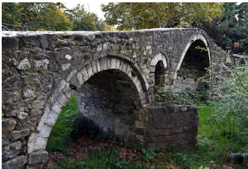
Fig. 47: Vista del ponte di Tabakëve
