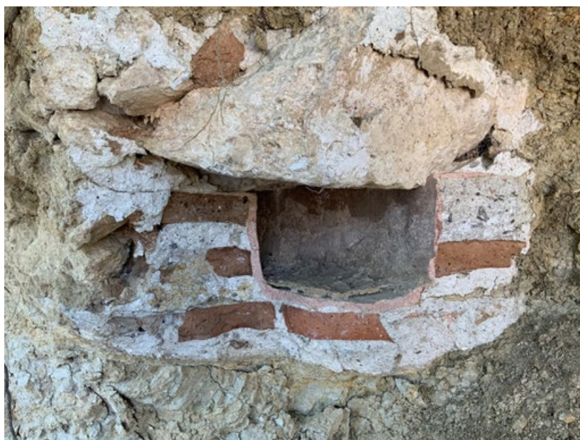
Fig. 100: Frammento delle tubazioni idriche
