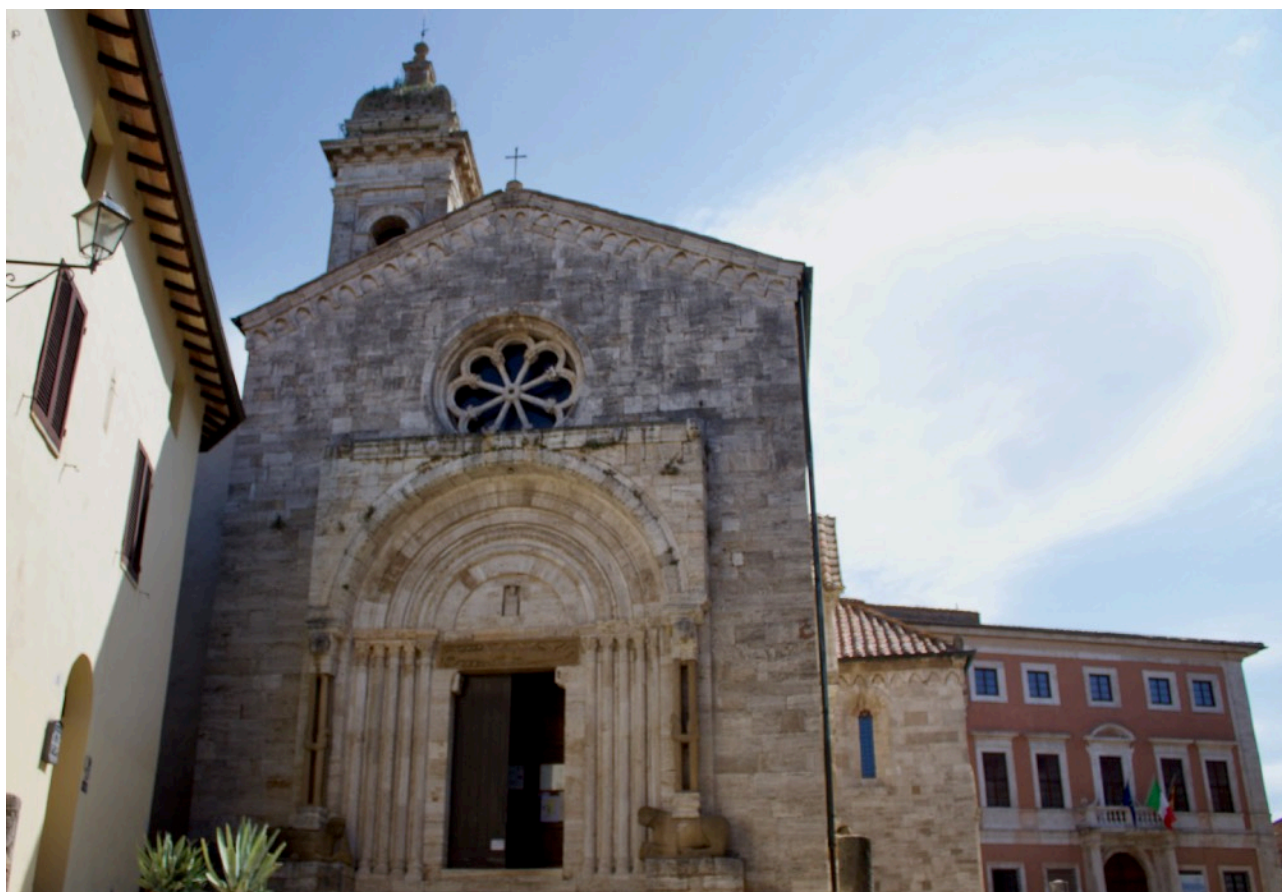
Facciata, Collegiata dei Santi Quirico e Giulitta, San Quirico d'Orcia.
