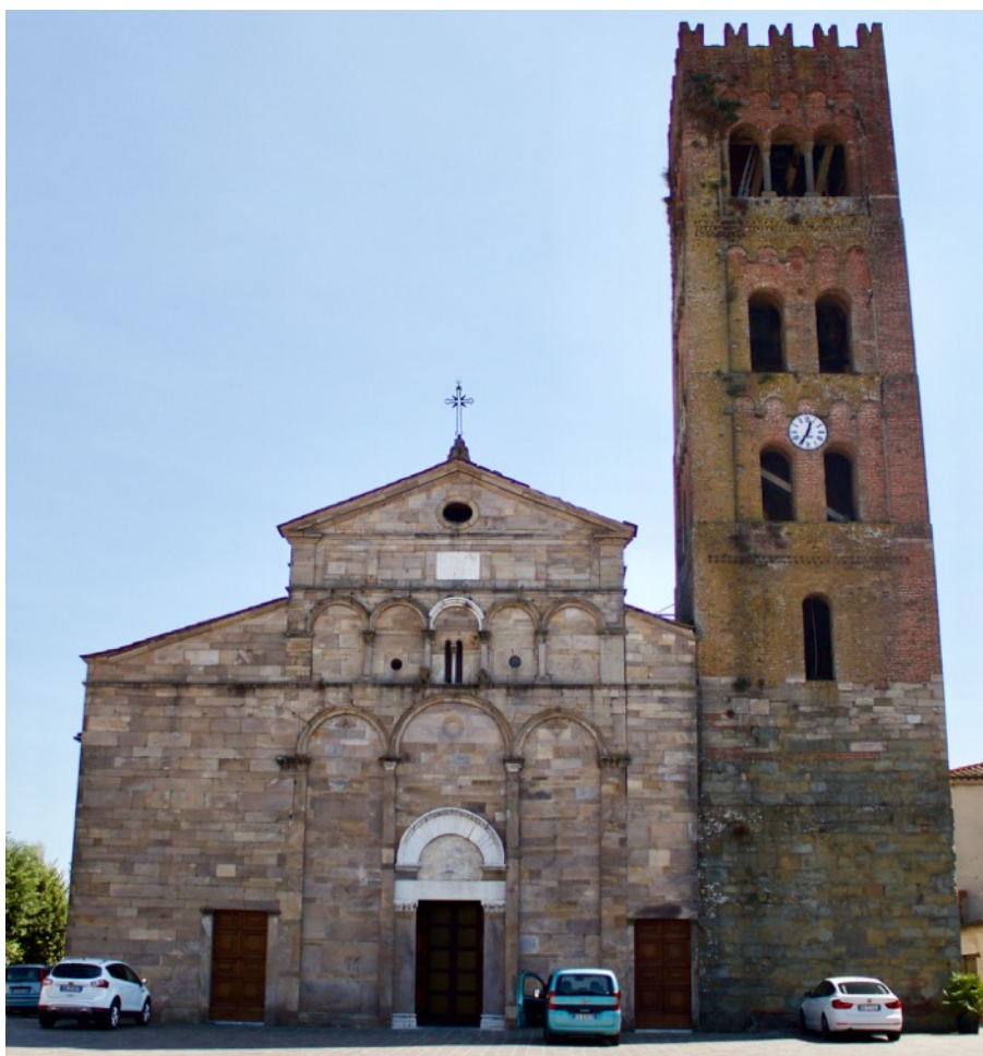
Facciata, Chiesa dei Santi Quirico e Giulitta, Capannori.
