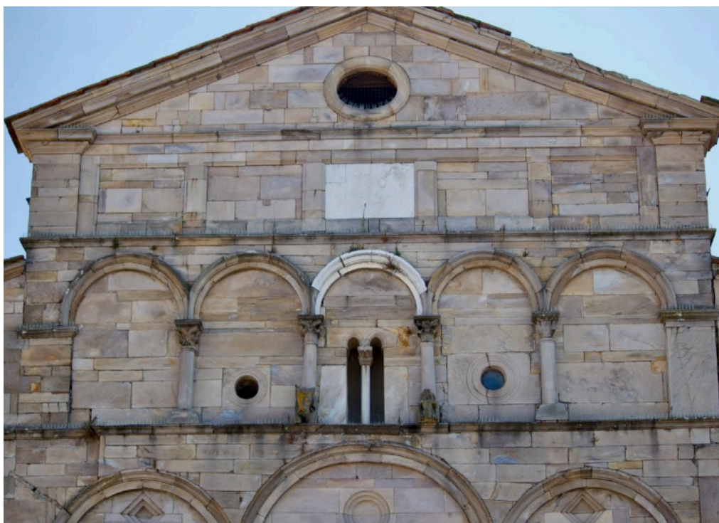
Sezione superiore del prospetto, Chiesa dei Santi Quirico e Giulitta, Capannori.
