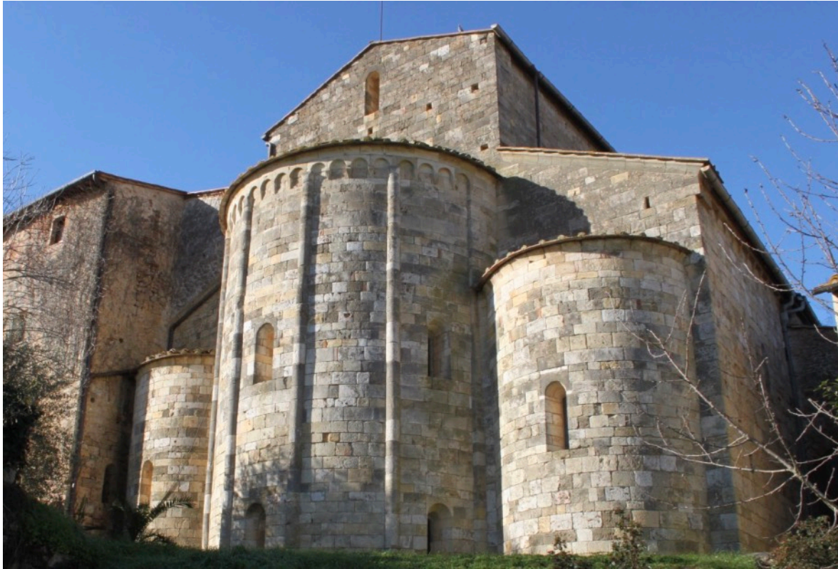
Zona absidale, abbazia dei Santi Salvatore e Cirino a Isola.
