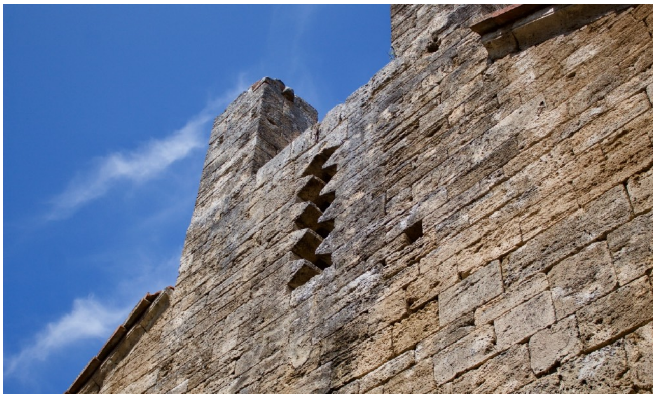
Feritoia, facciata, Chiesa di San Giovanni in Jerusalem, Poggibonsi.
