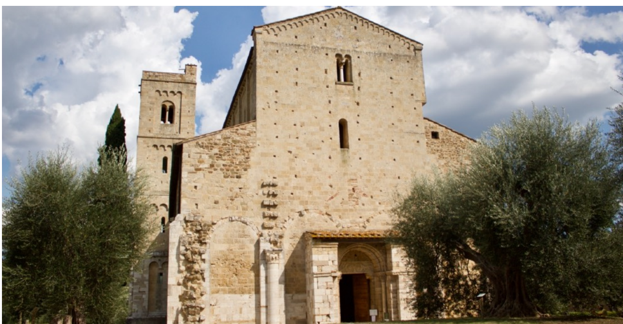
Facciata, abbazia di Sant’Antimo, Castelnuovo dell’Abate.
