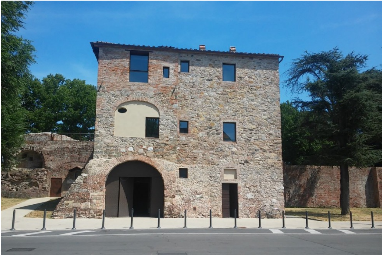
Via Francigena Entry Point, Casa del Boia, Lucca. 7
