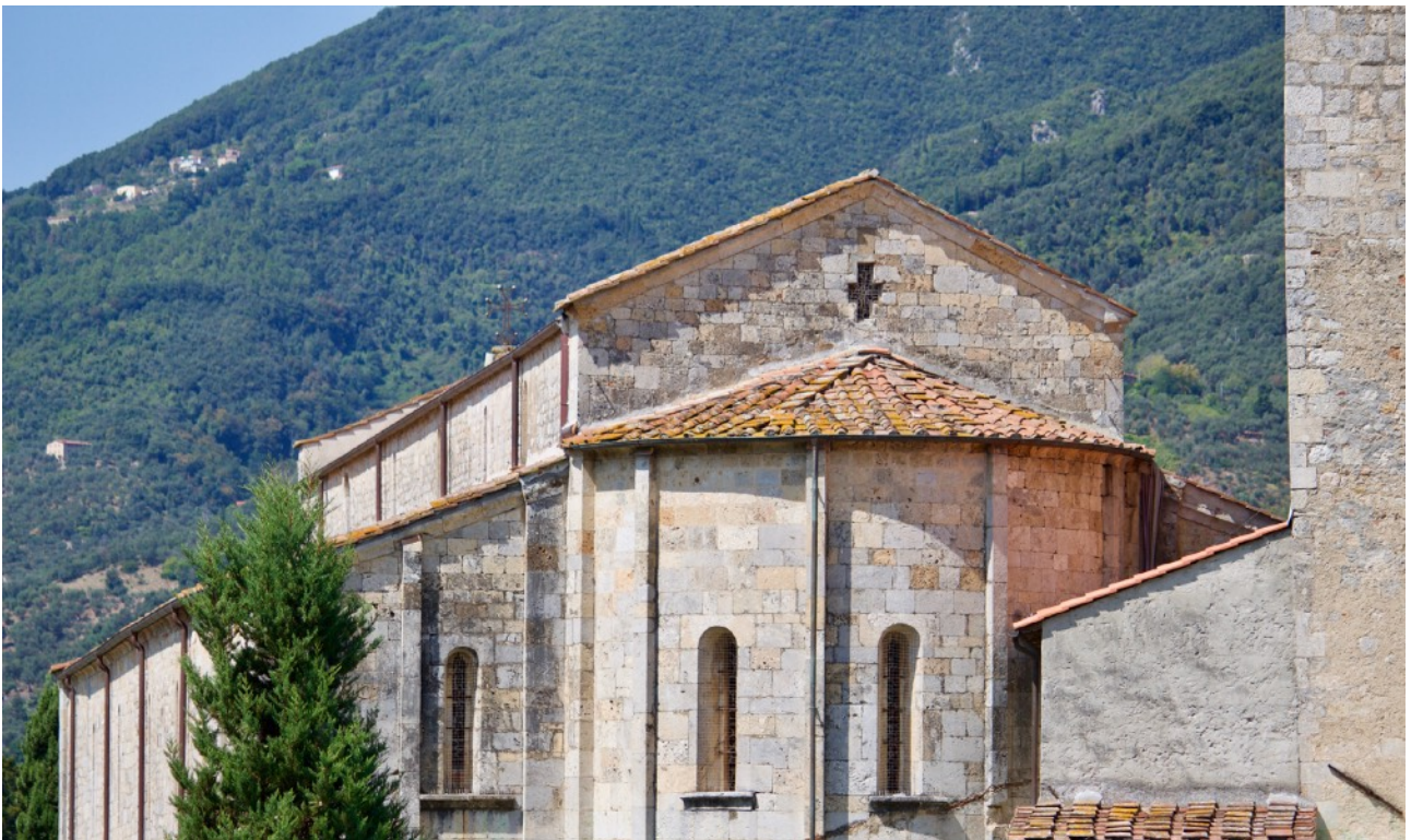
Zona absidale, badia di San Pietro, Camaiore.
