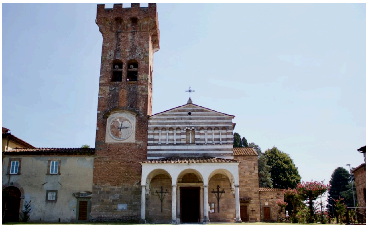
Facciata, pieve di San Paolo, Capannori.
