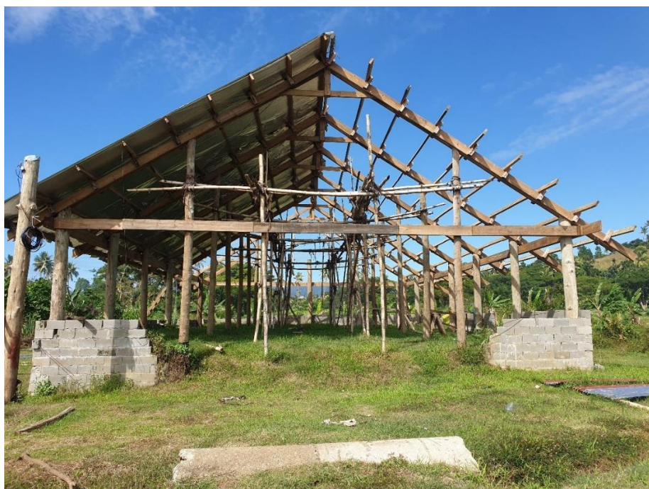
Figura 33 - La chiesa nel villaggio di Silana è ancora in fase di ricostruzione nel 2019. Anche qui le risorse economiche utilizzate per la ricostruzione provengono quasi interamente da iniziative di autofinanziamento interne alla comunità (Beatrice Ruggieri).
