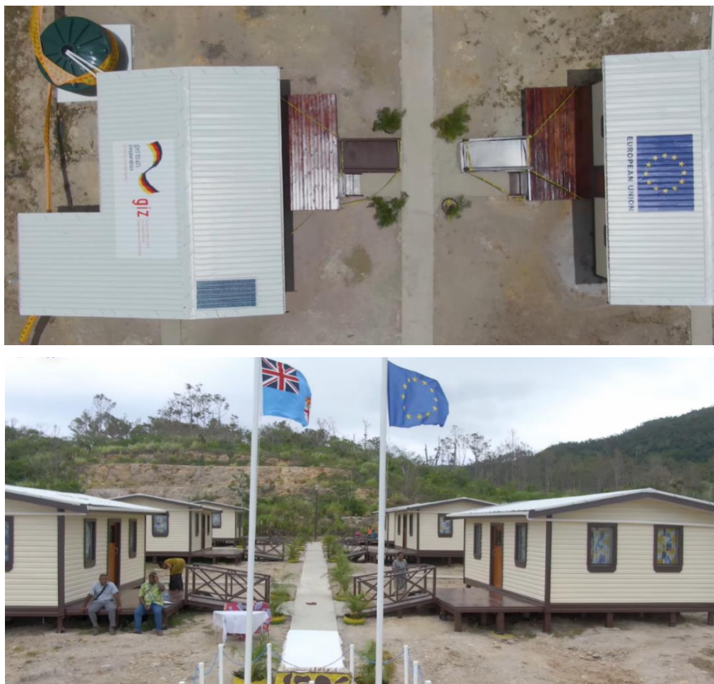
Figura 12 - Alcuni fotogrammi estratti dal video di presentazione della rilocalizzazione di Narikoso che il primo ministro Bainimarama ha pubblicato sulla propria pagina Facebook il 20 novembre 2020. Oltre alla standardizzazione degli edifici ricostruiti, anche da questi semplici fotogrammi è possibile notare come i finanziatori del progetto di rilocalizzazione siano ben presenti all'interno dello spazio del nuovo villaggio. Lo si vede dalle bandiere issate ma anche e soprattutto dalle scritte sui tetti delle abitazioni che contribuiscono in qualche modo a “brandizzare” il progetto rendendolo “facilmente” replicabile in altri contesti e su scale diverse.
