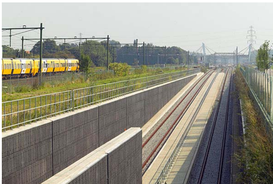
Figura 7-13 Rete RTE-T – Linea Betuwe – Imbocco del tunnel di Zevenaar
