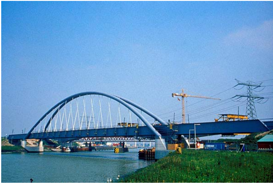
Figura 7-10 Rete RTE-T – Linea Betuwe – Il ponte di Dintelhaven
