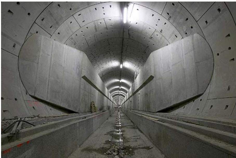
Figura 7-11 Rete RTE-T – Linea Betuwe – Il tunnel di Sophia
