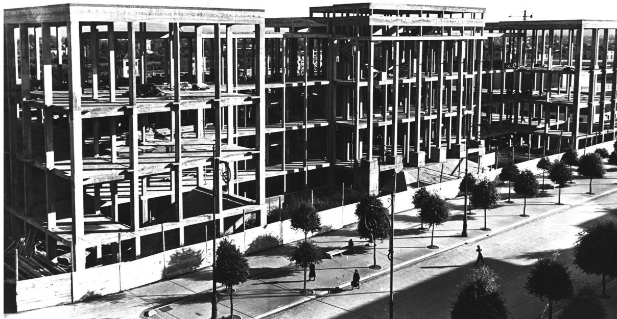
Fig. 115 A. Fuzzi, Istituto Tecnico Industriale. La fitta rete intelaiata in calcestruzzo armato. ATRIUM, Archivio digitale .
