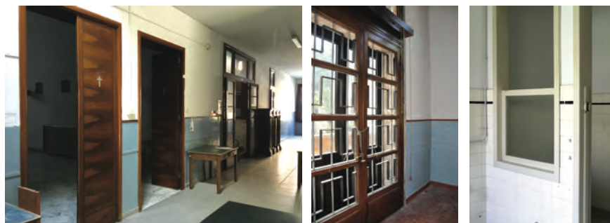
Fig. 148 G. Savini, Asilo Santarelli. Infissi in legno. Foto: G. FAVARETTO, 2018.
