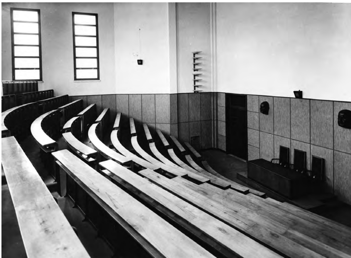
Fig. 131 A. Fuzzi, Istituto Tecnico Industriale. Aula magna, rivestimenti murali in Linoleum con inquadature in legno di ontano. ATRIUM, Archivio digitale .
