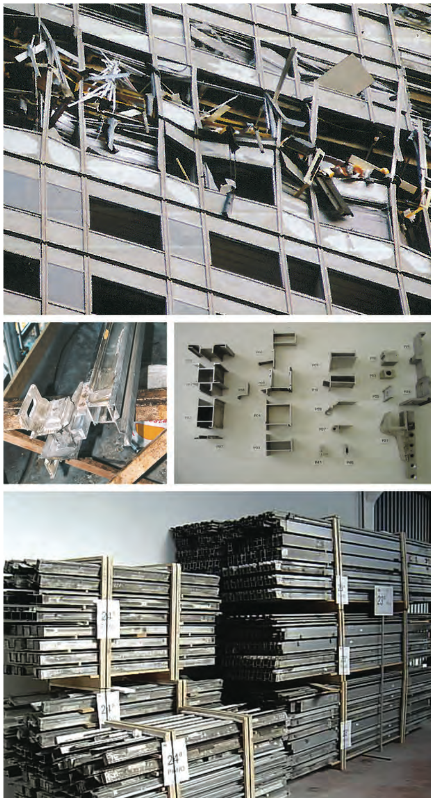
Fig. 236 Grattacielo Pirelli, Milano. Dall'alto: i serramenti dell'edificio dopo l'impatto dell'aereo; le componenti degli infissi durante e dopo la fase di smontaggio. M.A. CRIPPA, 2007, pp. 46, 82; APCM.
