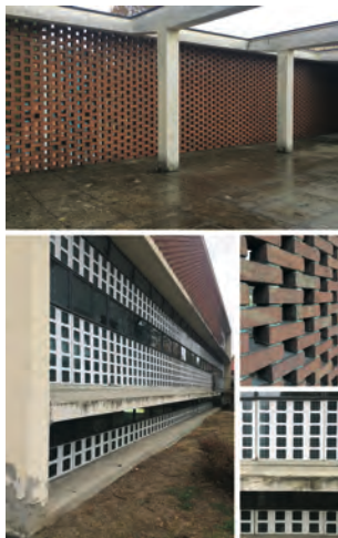
Fig. 191 Dispensario Antitubercolare, Alessandria. Dall'alto: solarium ; prospetto principale con coesistenza di laterizio e vetrocemento. Foto: G. FAVARETTO, 2017.
