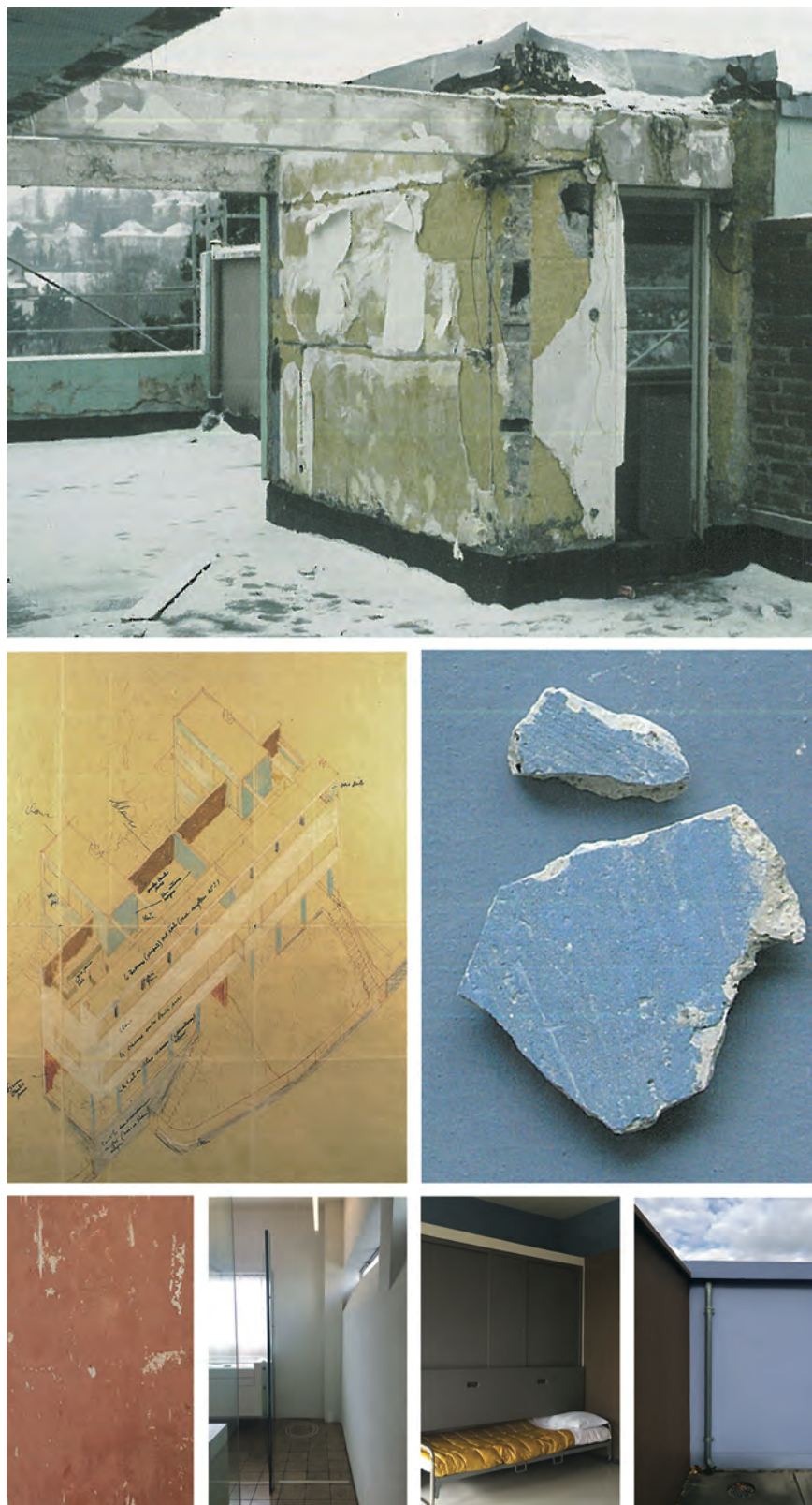
Fig. 204 Quartiere Weissenhof, Stoccarda. Le Corbusier e P. Jeanneret, casa doppia ( Haus 14-15 ). Dall'alto: il tetto-giardino nel 1983; le cromie ritenute originarie sulla base della documentazione rinvenuta e dei campioni su materiali pur segnati dal tempo; l'edificio nel 2017. C. MOHN, 2007, p. 32; H.F. REICHWALD, 2008, p. 59; G. ADLBERT, 2006, p. 144; foto: G. FAVARETTO, 2017.
