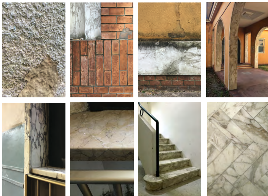
Fig. 123 G. Savini, Asilo Santarelli. L'alternanza tra superfici intonacate, laterizi e rivestimenti lapidei. Foto: G. FAVARETTO, 2017-2018.
