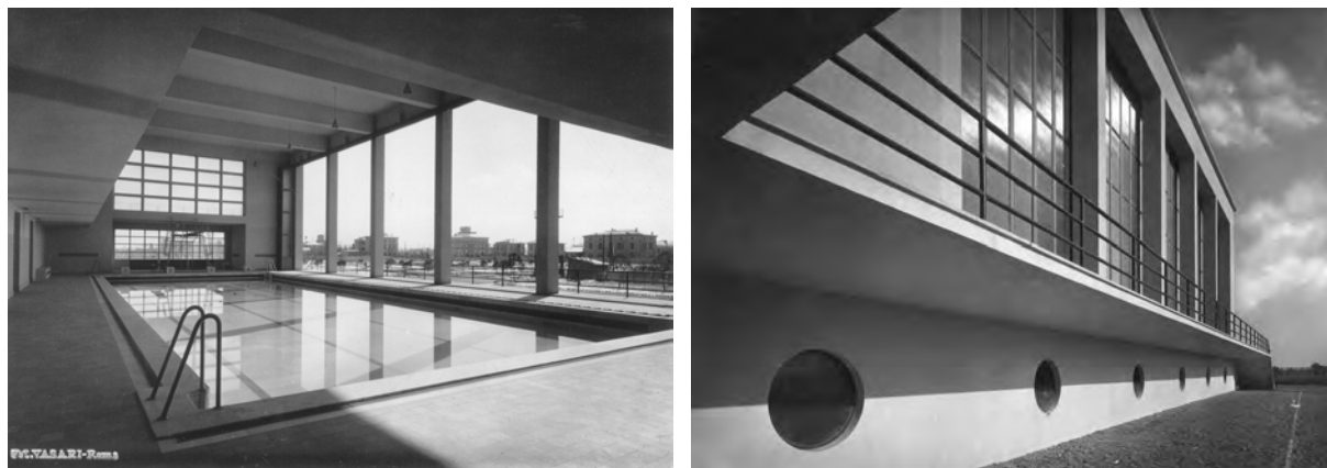
Fig. 143 C. Valle, Casa del Balilla. Parete vetrata aperta nel volume della piscina e oblò nel basamento. AV-Roma, Fotografie , scatola 25, fasc. CV-FOT/039.
