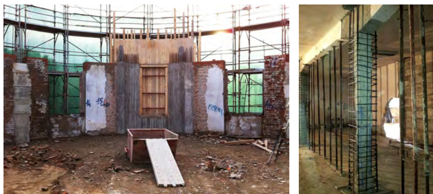
Fig. 111 C. Valle, Casa del Balilla. Da sinistra: inserimenti in calcestruzzo armato all'interno dei setti murari esistenti; realizzazione delle fodere in calcestruzzo armato per i pilastri nel seminterrato. Foto: A. GENTILI, 2010.
