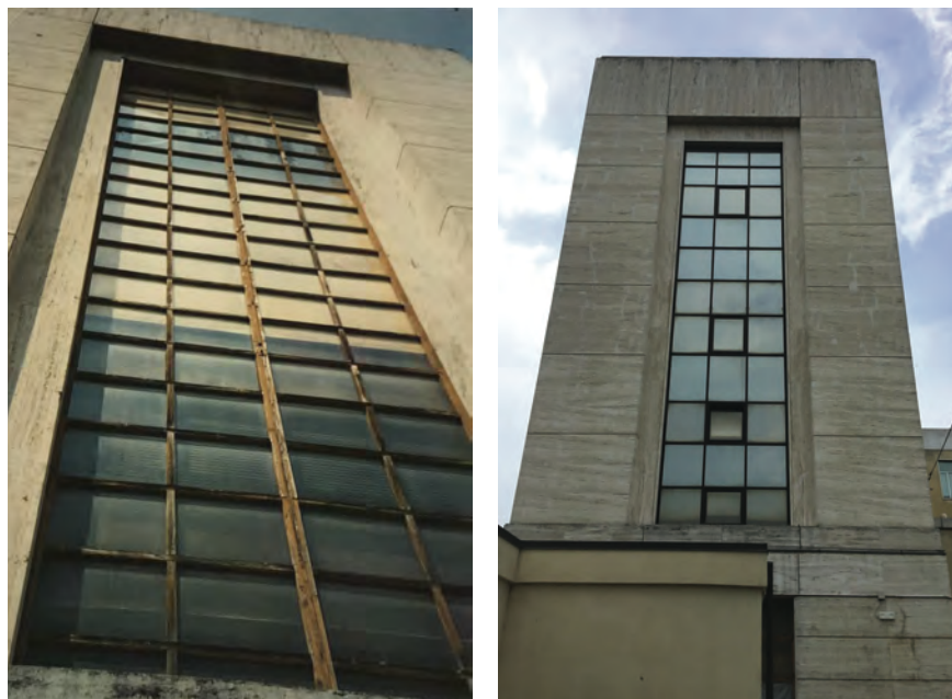
Fig. 153 A. Fuzzi, Istituto Tecnico Industriale. Parete vetrata in legno di larice sostituita da un serramento in alluminio. SABAP-RA, Archivio deposito , b. 1 «Fo. Forlì»; foto: G. FAVARETTO, 2018.
