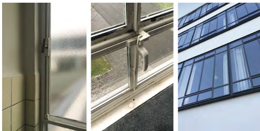
Fig. 240 Bauhaus, Dessau. Da sinistra: infisso del 1926 nel blocco dei dormitori; serramento del 1976 nel passaggio sospeso; infissi con vetrocamera del XXI secolo. Foto: G. FAVARETTO, 2017.
