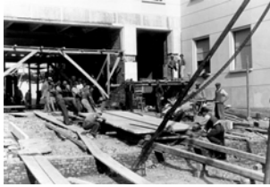
Fig. 104 C. Valle, Collegio Aeronautico. Il “secondo cantiere” dell’edificio. AV-Roma, Carteggio e allegati ai progetti, fald. 8, fasc. CV- CAR/044.
