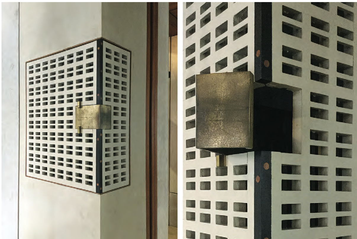
Fig. 250 Negozio Olivetti, Venezia. Pannelli a griglia, con apertura in ottone, per la schermatura del termosifone ancora in funzione. Foto: G. FAVARETTO, 2017.
