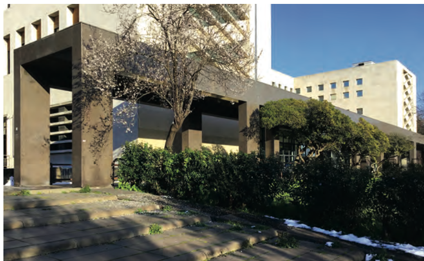
Fig. 216 Palazzo delle Poste di via Marmorata, Roma. Il portico di ingresso dopo l'intervento di ripristino. Foto: G. FAVARETTO, 2018.
