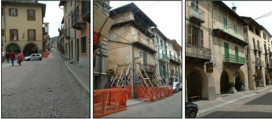
Fig. 5.1: Documentazione fotografica sullo stato della pavimentazione esistente
