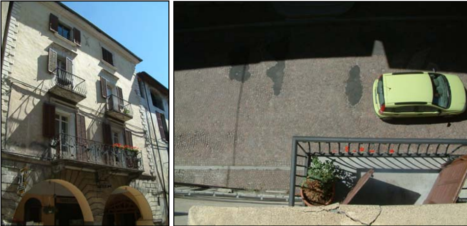
Fig. 5.9: Sezione strumentata 2: vista dell'edificio dalla SS 21 e piano viabile
