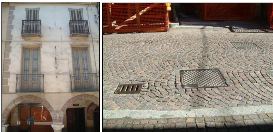
Fig.5.8: Sezione strumentata 1: vista dell’edificio dalla SS21 e pavimentazione
