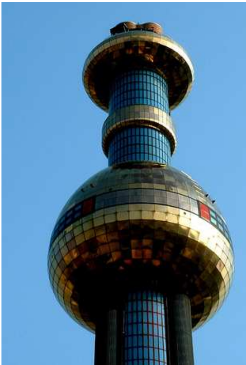
Impianto di teleriscaldamento Spittelau, Vienna. (Fonte: web, www.kunsthhauswien.com )
