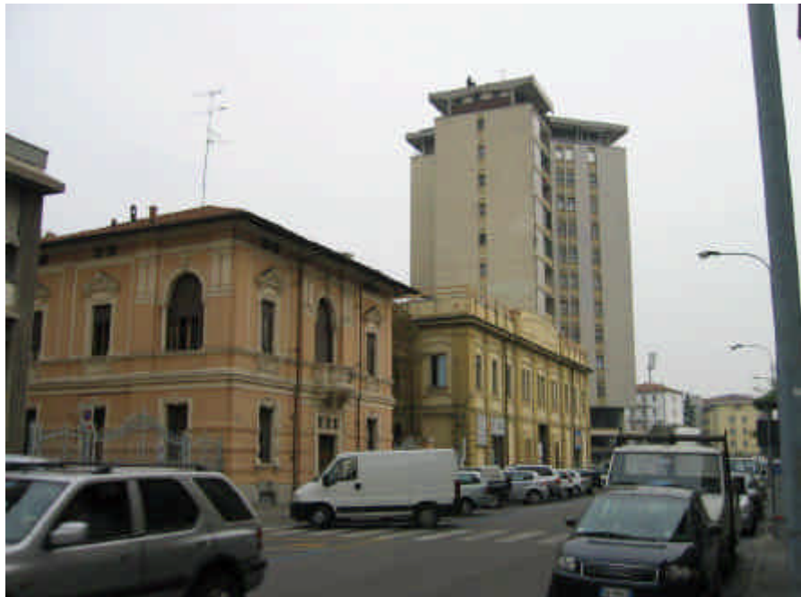
Vista dell'edificio a torre in prossimità di Porta San Pietro
