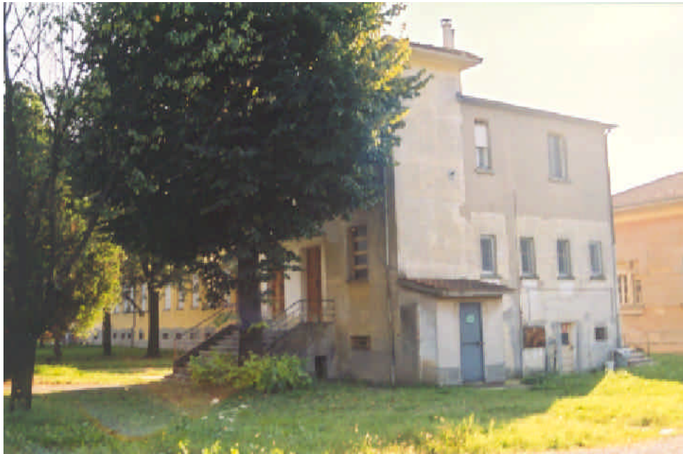
Edifici da riqualificare
