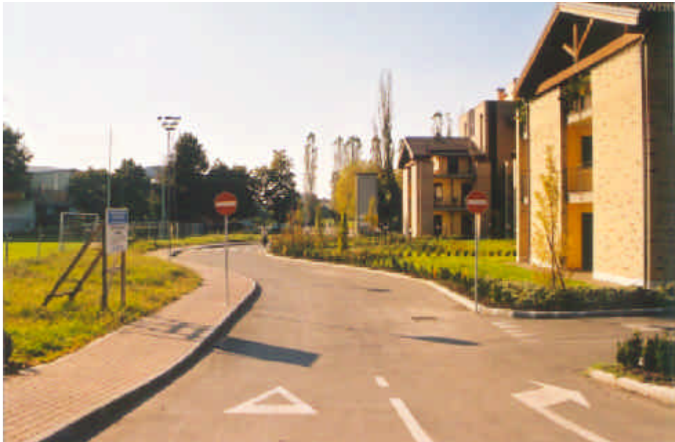
Vista di edifici del contesto circostante all'area d'intervento
