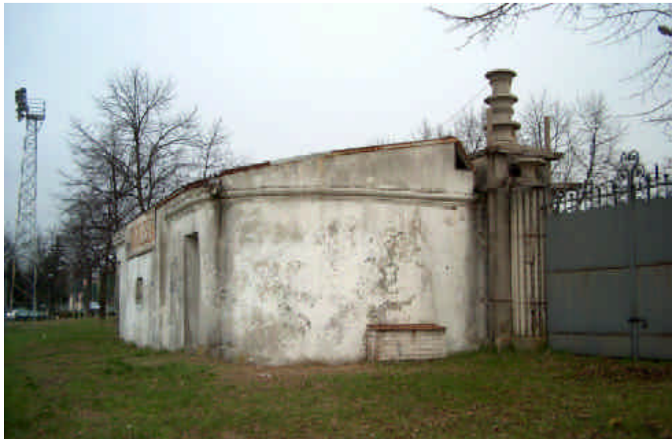
Vista della porta di accesso per la quale si prevede il restauro conservativo
