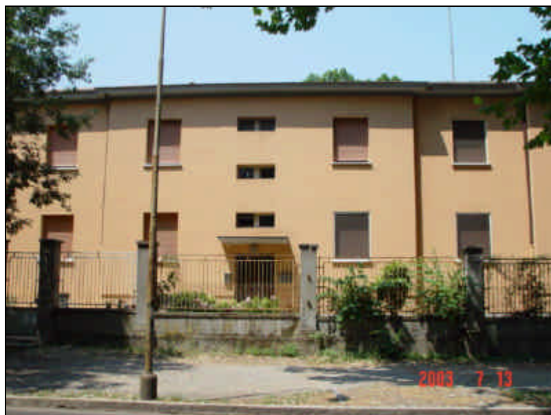
Vista dell'edificio per il quale si ipotizza la demolizione senza ricostruzione
