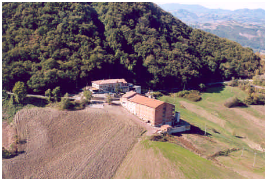
Viste dell'edificio incongruo
