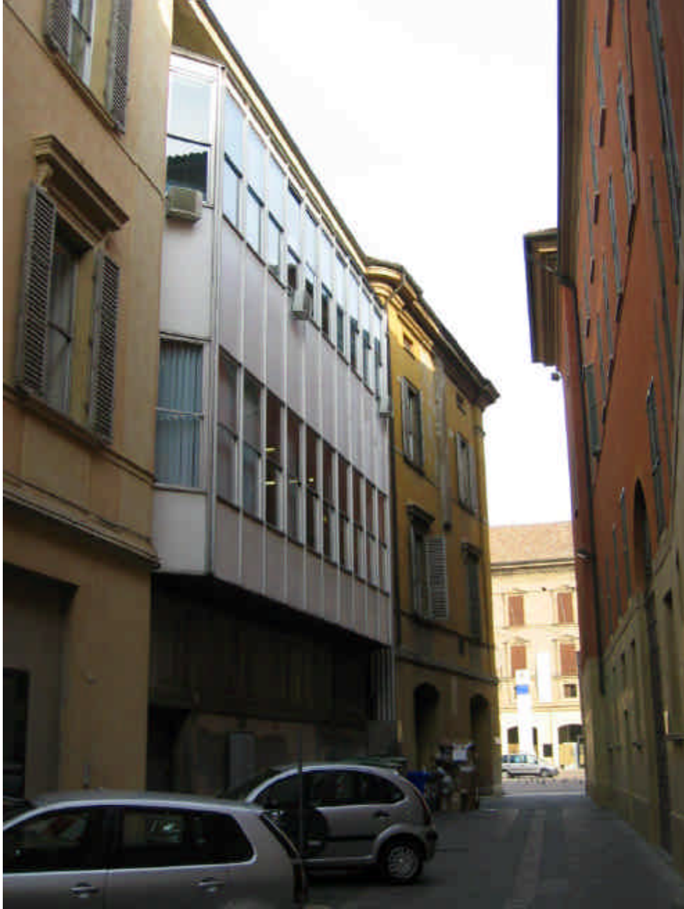
Vista di un edificio con caratteri metrico-costruttivi contrastanti con il contesto
