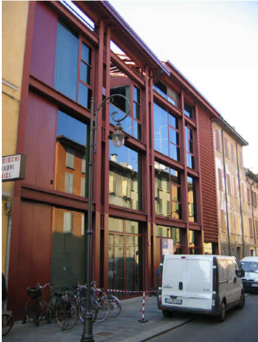
Vista di un edificio a struttura intelaiata in acciaio inserito in aderenza a edificio di del tessuto storicizzato di base
