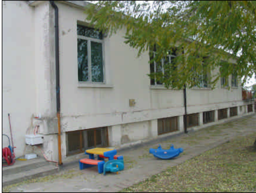
Vista dell'edificio nel suo stato di obsolescenza
