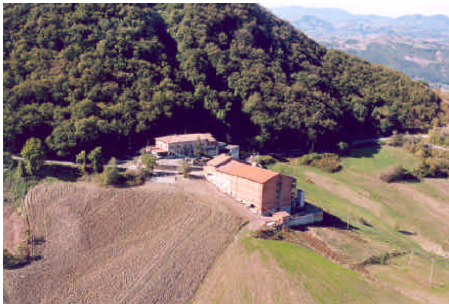
Vista dell'edificio produttivo Porcilaia di Canossa
