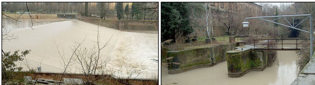
Figura 3.8. Chiusa di Casalecchio, sul fiume Reno (sinistra) e antico sostegno della Bova, sullo sfondo l'uscita dal tratto tombato (destra).
