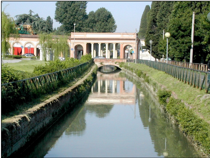
Figura 3.2. Aspetto attuale del Canale di Reno, nei pressi di Via della Certosa.
