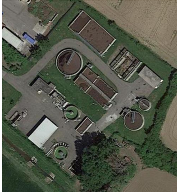
Fig. 5.1 - Granarolo dell'Emilia wastewater treatment plant.
