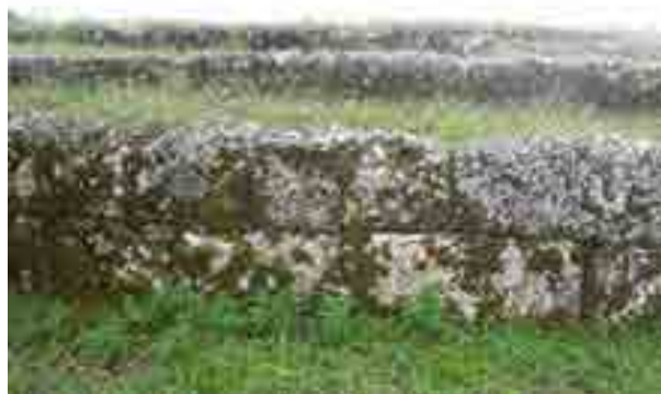
Fig. 14. Il muro di rinforzo in opera rettangolare isodoma.
