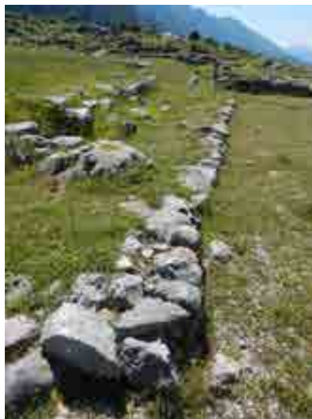
Fig. 166. Muro del limite nord-occidentale della piazza.
