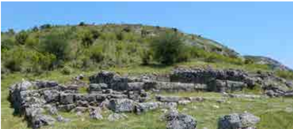
Fig. 113. L'Edificio E visto da sud.
