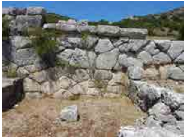
Fig. 273. Il muro settentrionale con l'alloggio per il solaio del primo piano.
