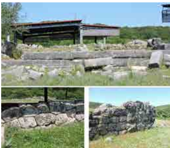
Fig. 126. Le diverse tecniche murarie impiegate nell'edificio.
