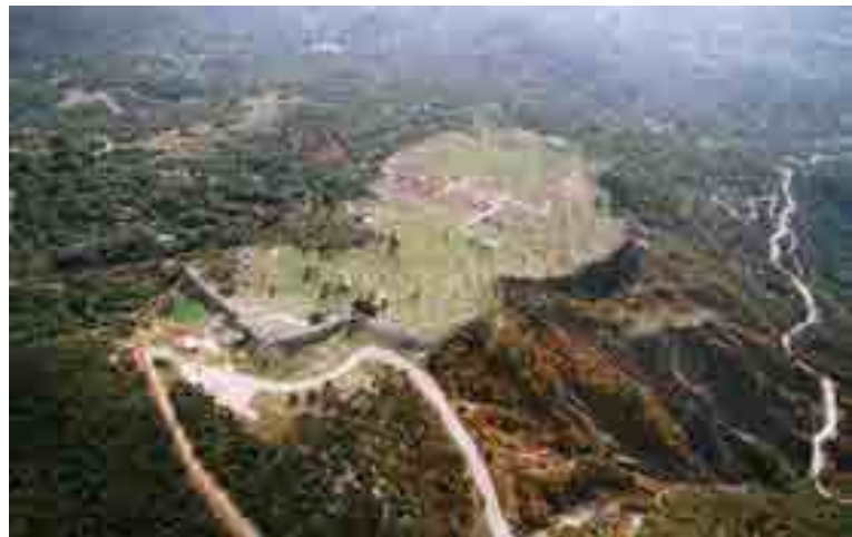
Fig. 154. Veduta aerea di Elea (KANTA-KITSOU 2009: 40).
