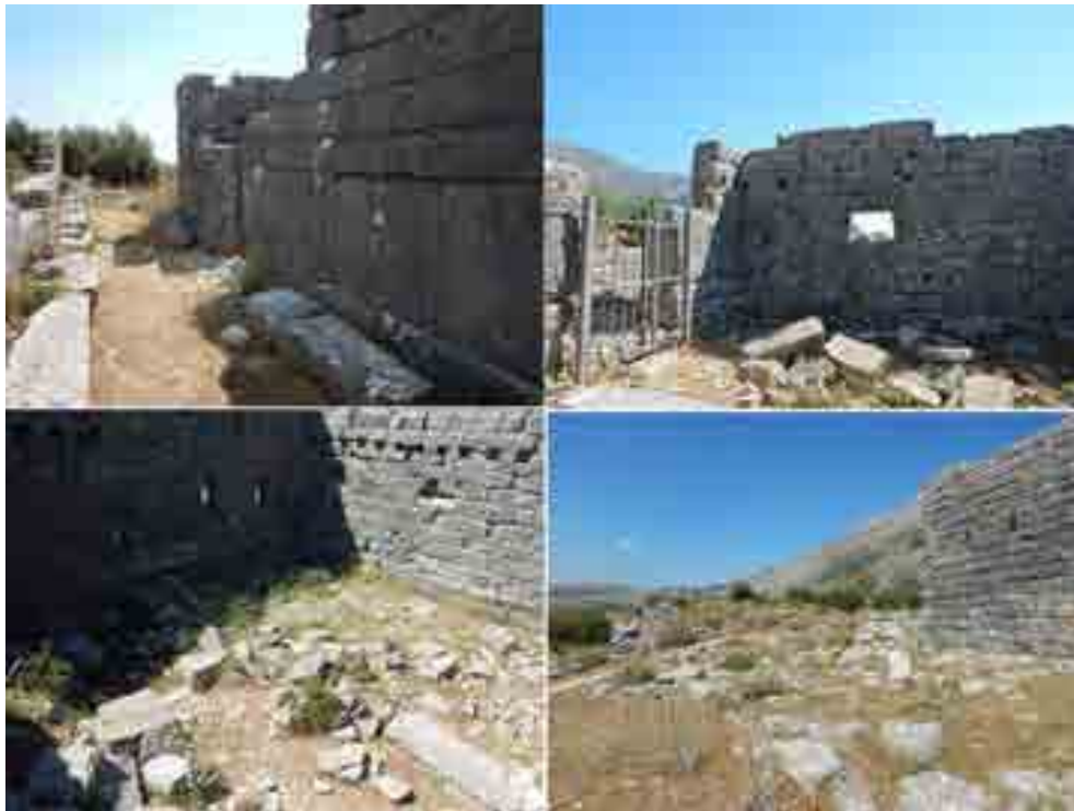
Fig. 292. La facciata con gli ortostati, l'interno dell'edificio e lo spazio aperto a ovest del corpo centrale.
