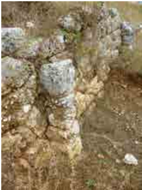
Fig. 25. Il muro di contenimento in opera poligonale con contrafforti.
