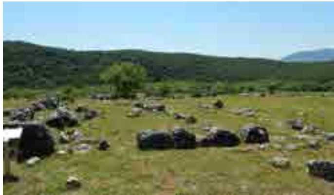
Fig. 122. Alcuni ambienti dell'Edificio commerciale.
