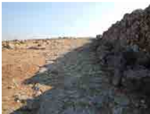
Fig. 139. Lo stenopos (m) che affianca a est l'edificio.
