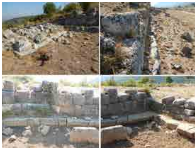
Fig. 110. La panca in muratura all'estremità occidentale e lungo il muro di fondo (in alto) e il tratto all'estremità orientale (in basso).
