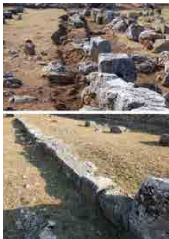
Fig. 171. Il muro sulla fronte in corso di scavo (AMIG: foto di scavo) (in alto) e dopo il restauro (in basso).
