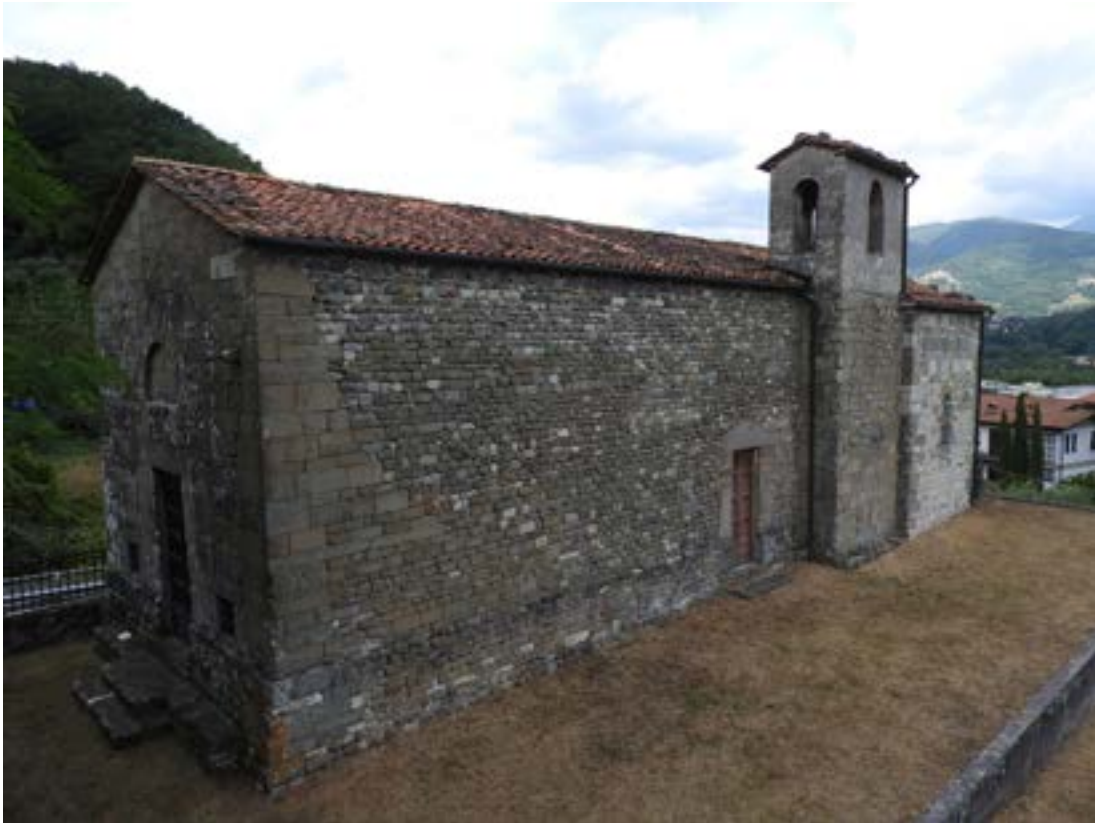
Fig. 12 – Chiesa di S. Maria, Galliciano (LU), vista da sud-ovest.
