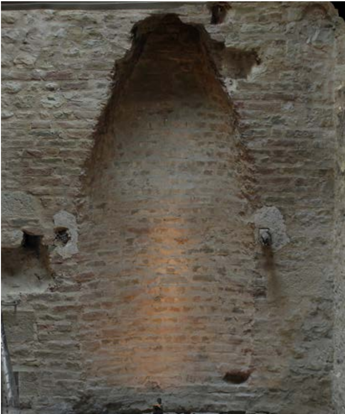
Fig. 51 - Torre di Rossenella, Canossa. Particolare del camino in muratura. Orthomosaico.
