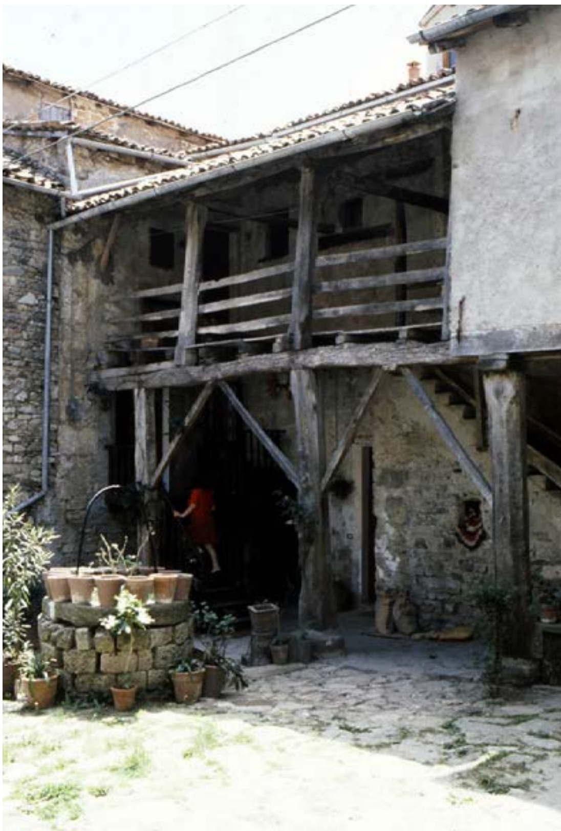
Fig. 49 - Pieve di Roffeno (BO). Esempio ben conservato di struttura lignea aggettante dalla casa.
