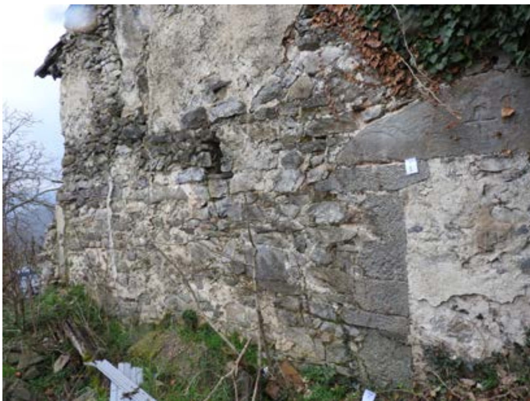
Fig. 3 - Pregheffio, dettaglio della fascia a spina di pesce.
