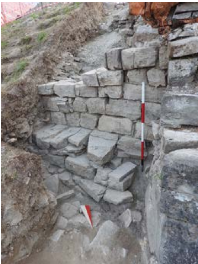
Fig. 13 - Castel Pizigolo, Toano (RE), Area 1000, Età medievale, muratura USM 106.
