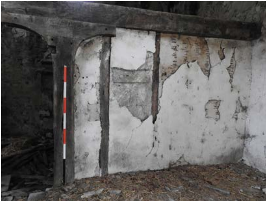
Fig. 56 - Cortevedola, Regnano. Tramezzo interno in opus craticium .
