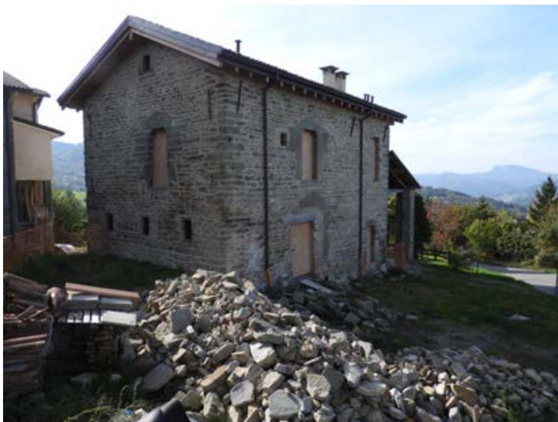
Fig. 15 - Stiano, Toano. Edificio di Tipologia 2.
