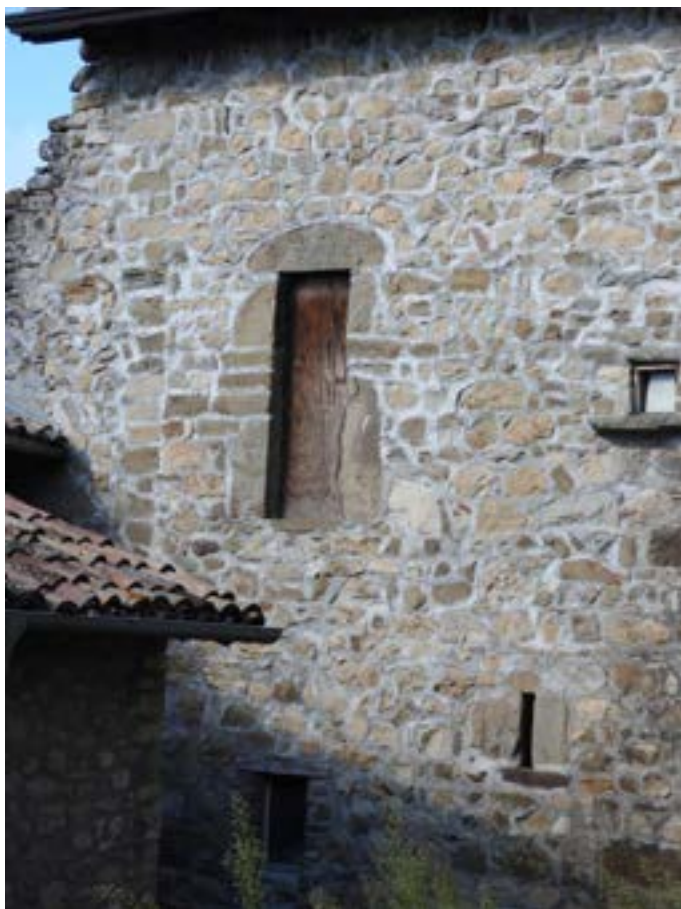
Fig. 20 - Gombio, località Villagrossa, Castelnuovo ne' Monti (RE), il CA2: il portale della seconda fase.
