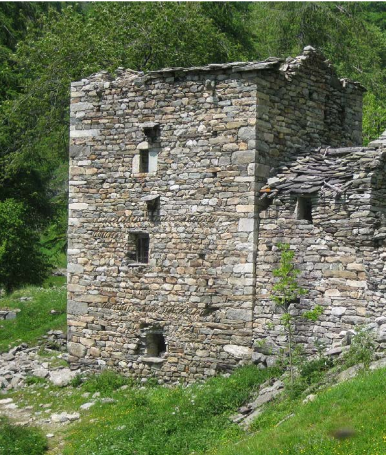
Fig. 10 - Ronco Canavese (TO), casaforte di Servino.
