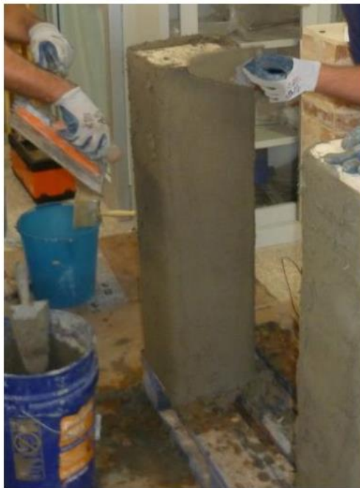
Fig. 72 – Realizzazione del pilastro rinforzato
