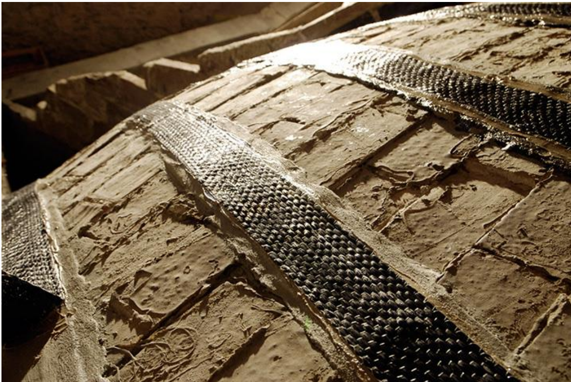
Fig. 2 – Rinforzo di una volta in muratura con FRP
