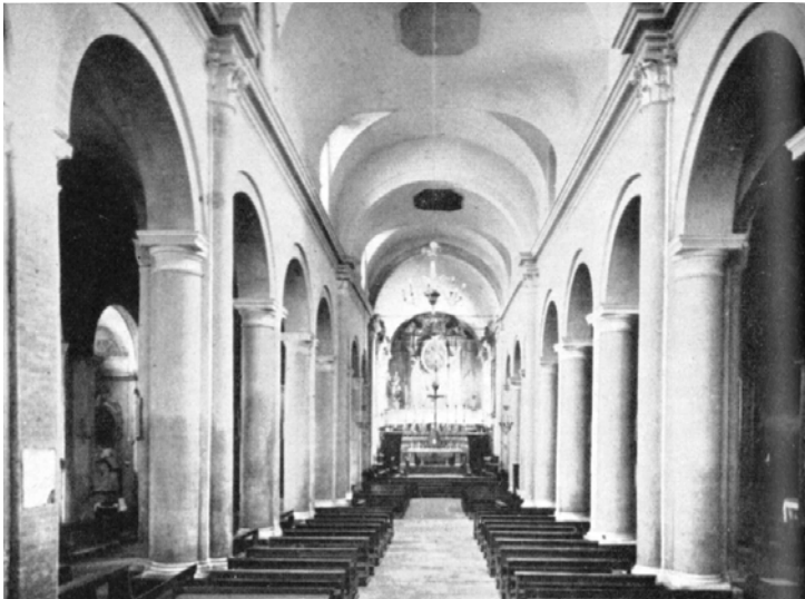
Fig.3 | Basilica di S.Mercuriale. Navata centrale prima del restauro
