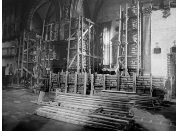
Fig. 2 | Opere di protezione antiaerea, interno
