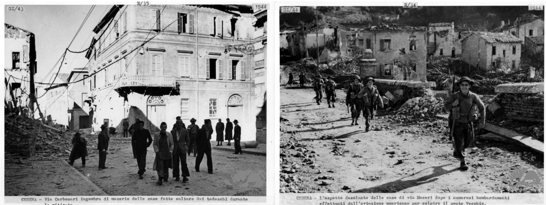
Fig.22_Cesena, i danni in via dei Carbonari e al Ponte San Martino
