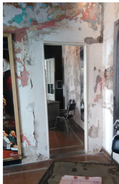
Fig. 4 - Sala in cui si può apprezzare la sovrapposizione delle mani di colore sui muri della struttura
