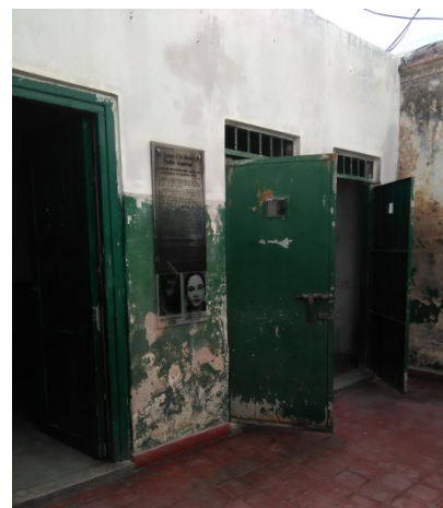
Fig. 7 – Patio delle celle
