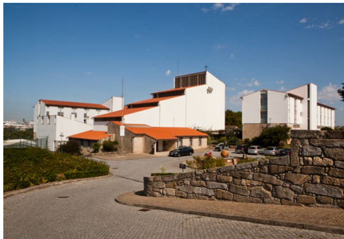
Fotografia di viaggio, Convento di Gondomar di F. Távora, settembre 2015. Il complesso conventuale dalla strada di accesso.
