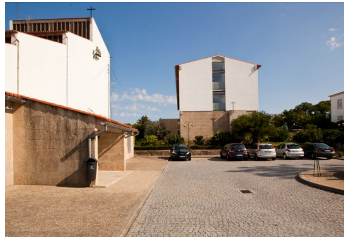
Fotografia di viaggio, Convento di Gondomar di F. Távora, settembre 2015. Ingresso principale e prospetto laterale del blocco del noviziato.
