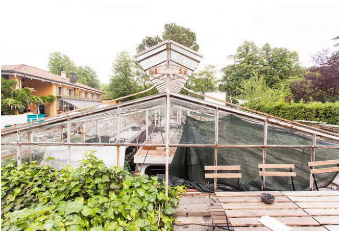
La "serretta" - "Coworking 95mq" - vista dal piazzale
