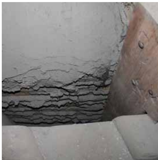
Fig. 54 – Teatro Comunale di Modena. Il supporto in cantinelle del plafone.
