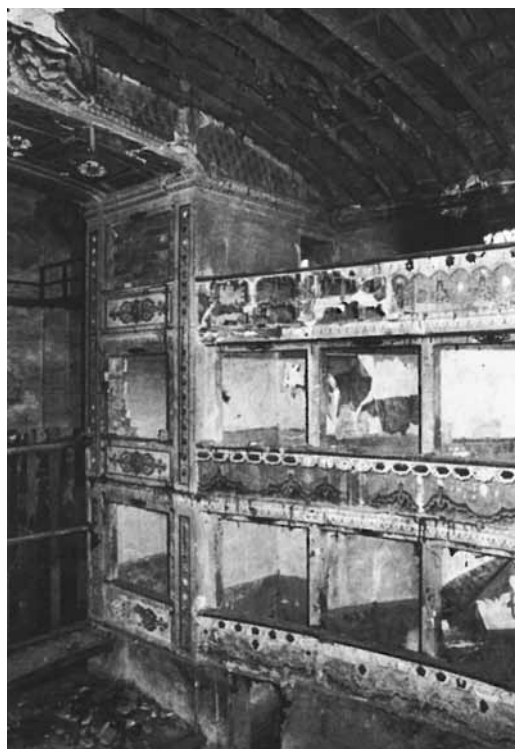
Fig. 28 – Cesenatico, Teatro Comunale (1865). Degrado della struttura del soffitto e delle decorazioni della sala (Da Bondoni S. M., Teatri storici in Emilia Romagna , Grafis, Bologna 1982, p. 32).
