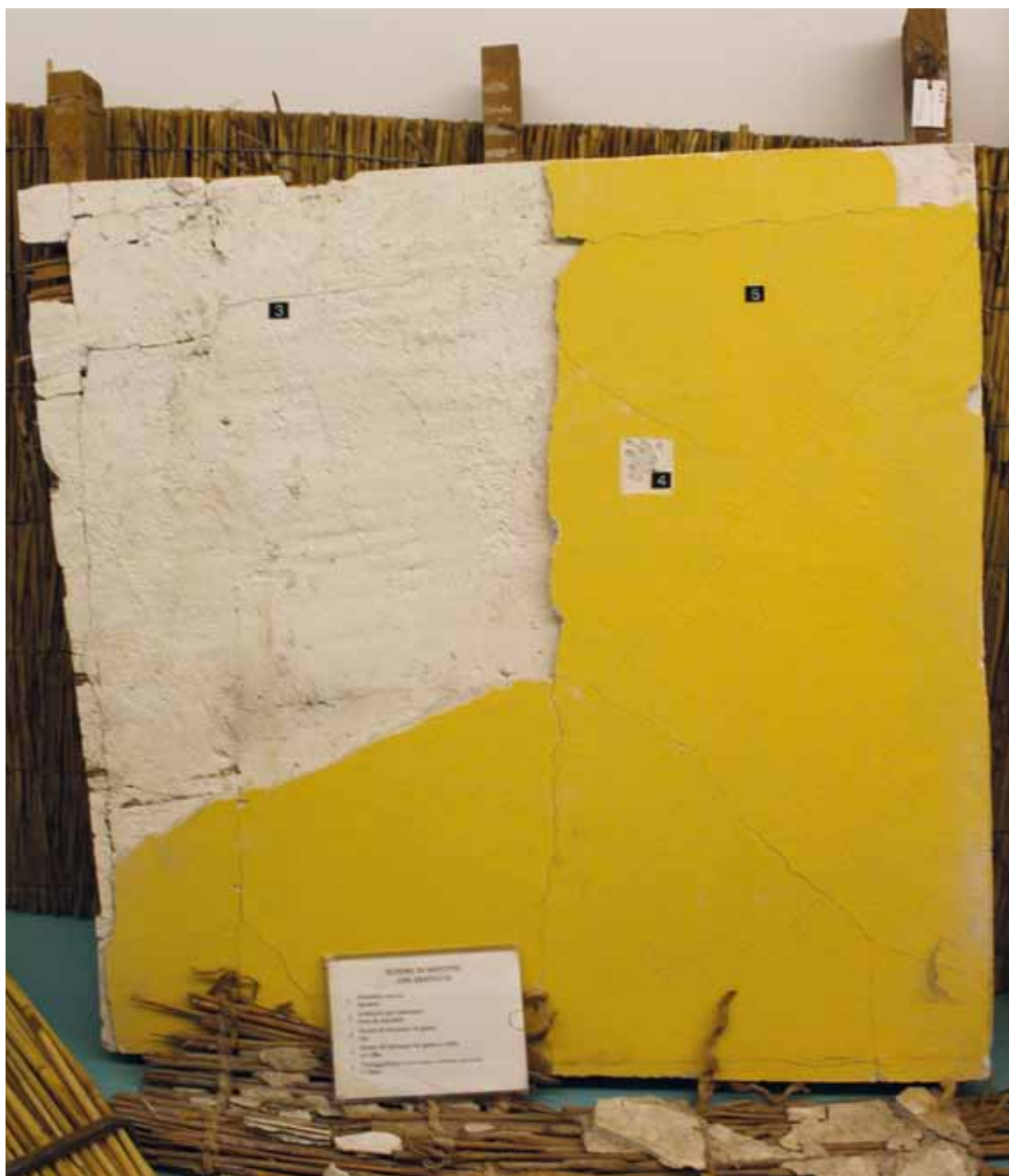
Fig. 54 – Sezione di soffitto con graticcio: 1, travetto; 2, graticcio per intonaco; 3, Strato di intonaco in gesso; 4, strato di intonaco in gesso e calce; 5, tinteggiatura di calce bianca o colorata con terre. Ecomuseo delle Erbe Palustri, Villanova di Bagnocavallo (foto 2015).
