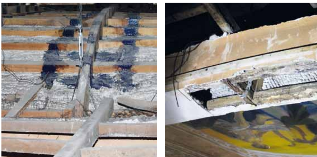
Figg. 81-82 – Teatro di Novi di Modena. Il nodo di appoggio della struttura centinata: si osservi la morfologia del prisma cavo che fa da “tamburo” di sostegno del plafone.
