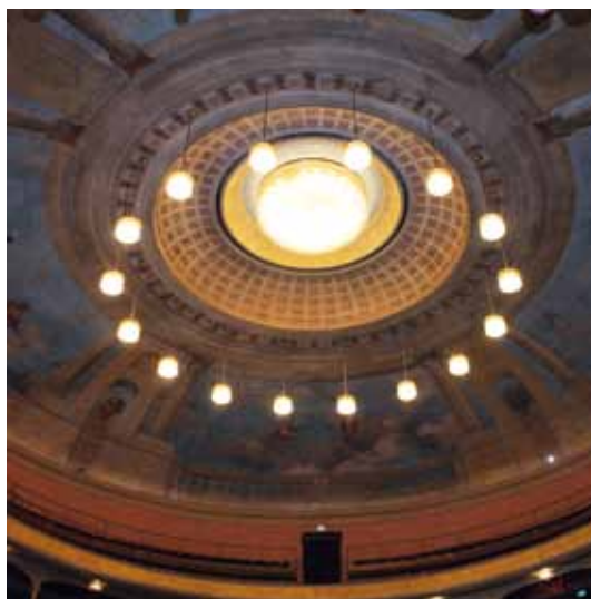
Fig. 167 – Le due calotte centrali della volta del Teatro Storchi a Modena.
