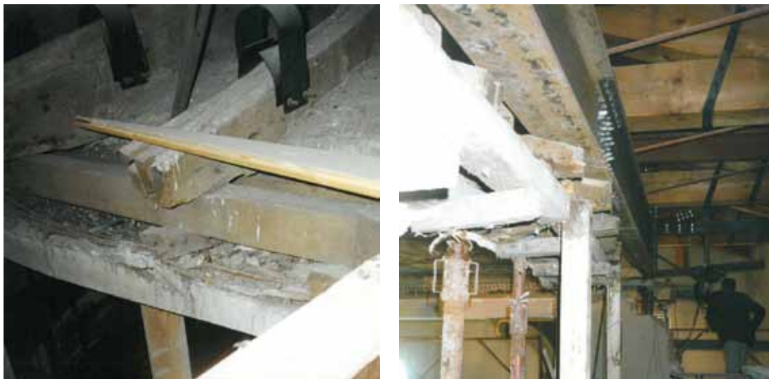
Figg. 84-85 – Teatro di Pieve di Cento. Il nodo di appoggio delle centine in uno scatto di cantiere dell'intervento del 2000 (Archivio dello Studio Guido Cavina Roberto Terra Architetti).
