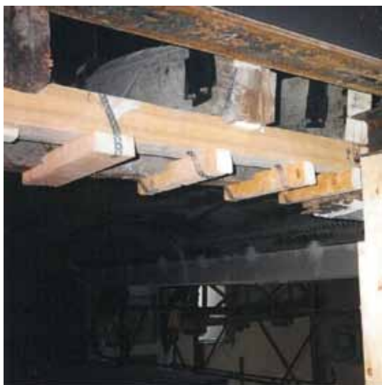
Fig. 86 – Teatro di Pieve di Cento. Rinforzo del nodo di appoggio con catenelle in acciaio e nuovi elementi lignei (Archivio dello Studio Guido Cavina Roberto Terra Architetti).
