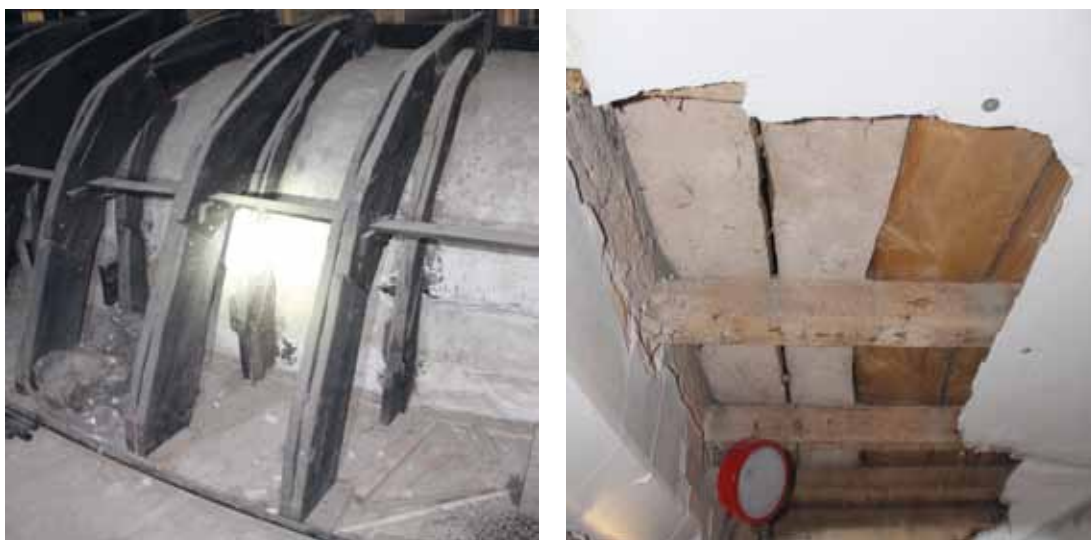
Figg. 88-89 – Teatro di Crevalcore. A sinistra, si osservi l'appoggio delle centine sul tavolato del solaio del sottotetto. A destra, il solaio del sottotetto composto di un doppio ordine di rustici sorretti da travetti lignei.
