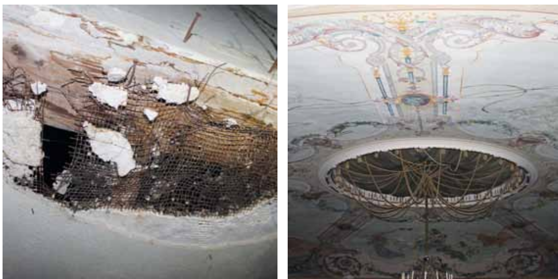
Figg. 5-6 – Plafone del Teatro Nuovo di Mirandola. La fitta rete metallica chiodata alle travi lignee; si osservino le macchie dovute a umidità di condensa estese sull'intradosso del soffitto.
