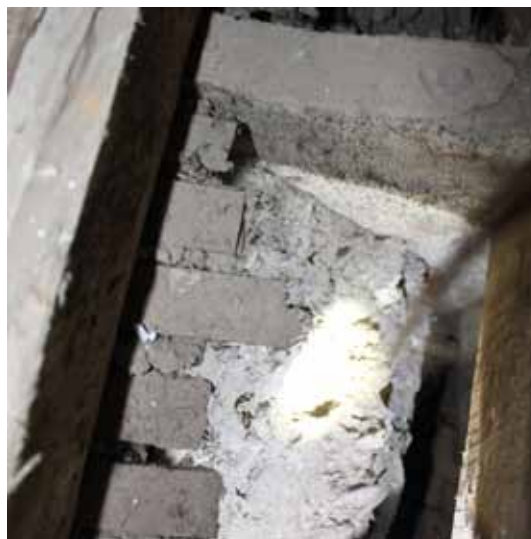
Fig. 57 – Teatro di Carpi. Il supporto in cantinelle del plafone.
