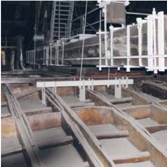
Figg. 121-122 – Teatro Comunale di Bologna. Piastre e tiranti di sostegno posti in opera con i grandi consolidamenti degli anni Ottanta.
