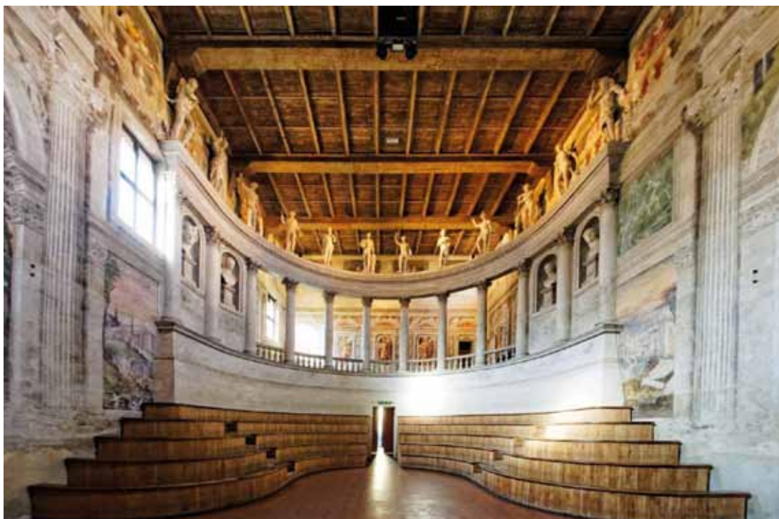
Fig. 3 – Sabbioneta, Teatro Ducale (1590). La copertura della sala è oggi priva dell'originario controsoffitto a finto cielo.
