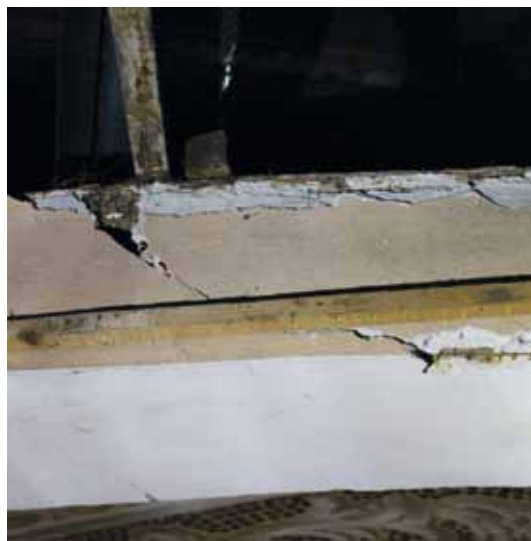
Fig. 61 – Teatro di Novi di Modena. La rete metallica di supporto dell'intonaco attorno ai "tamburi lignei" di sostegno del plafone.
