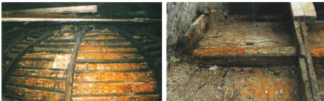
Figg. 10-11 – Differenti supporti in canne fatti di stuoie di canna comune (sinistra) e canne palustri intrecciate (destra) (da Quagliarini E., D’Orazio M., Recupero e conservazione di volte in “camorcanna” . Dalla “regola d’arte” alle tecniche d’intervento, Alinea, Firenze 2005, pp. 23, 67).
