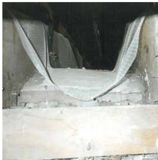
Fig. 184 – Teatro di Pieve di Cento. Fasciature in fibra di vetro e resina epossidica (Archivio dello studio Guido Cavina Roberto Terra Architetti).
