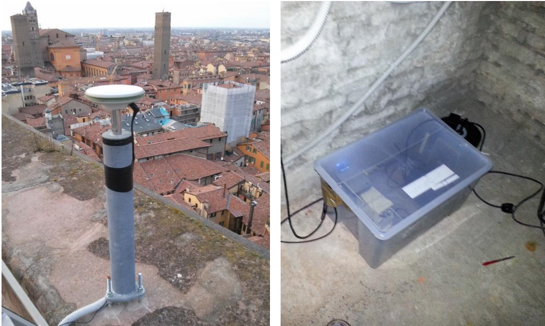
Figura 5.1 – Materializzazione della stazione GNSS sulla torre Garisenda
