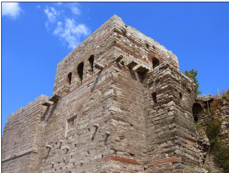
Torre di Isacco Angelo, particolare della muratura.
