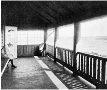
La lunga veranda al piano primo sul fronte sud
