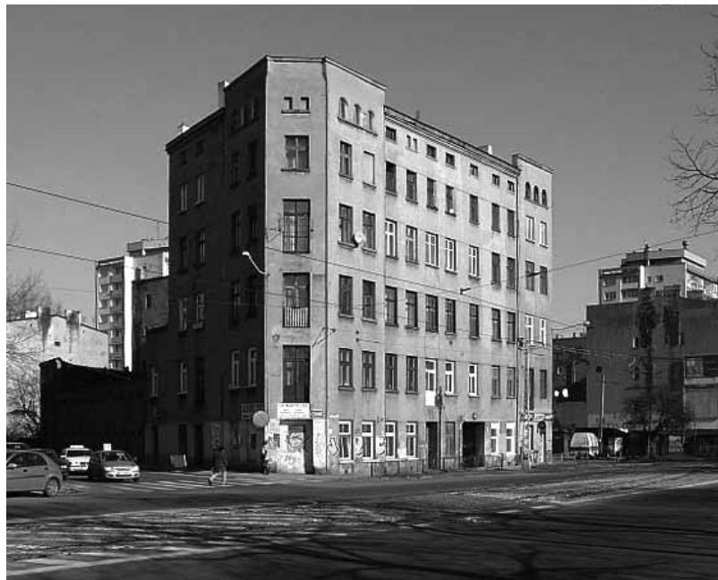
Edificio che ospitò il campo degli zingari all'interno del ghetto Lodz 2013
