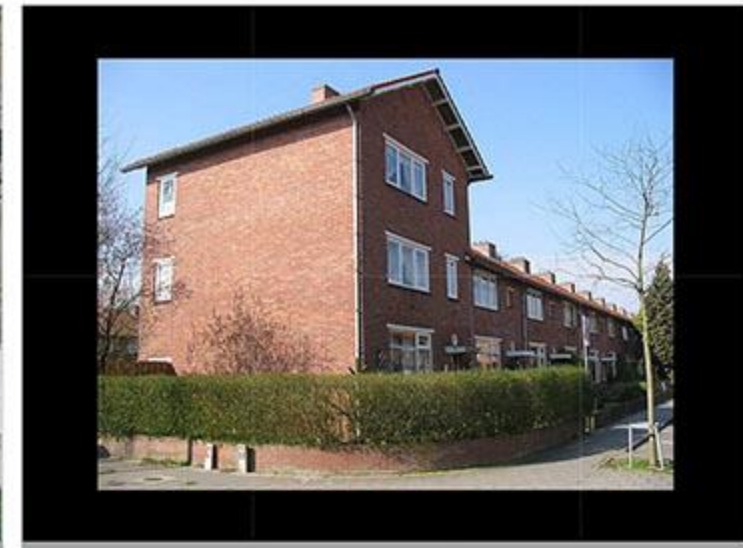
Foto 2: abitazioni su Weberstraat
