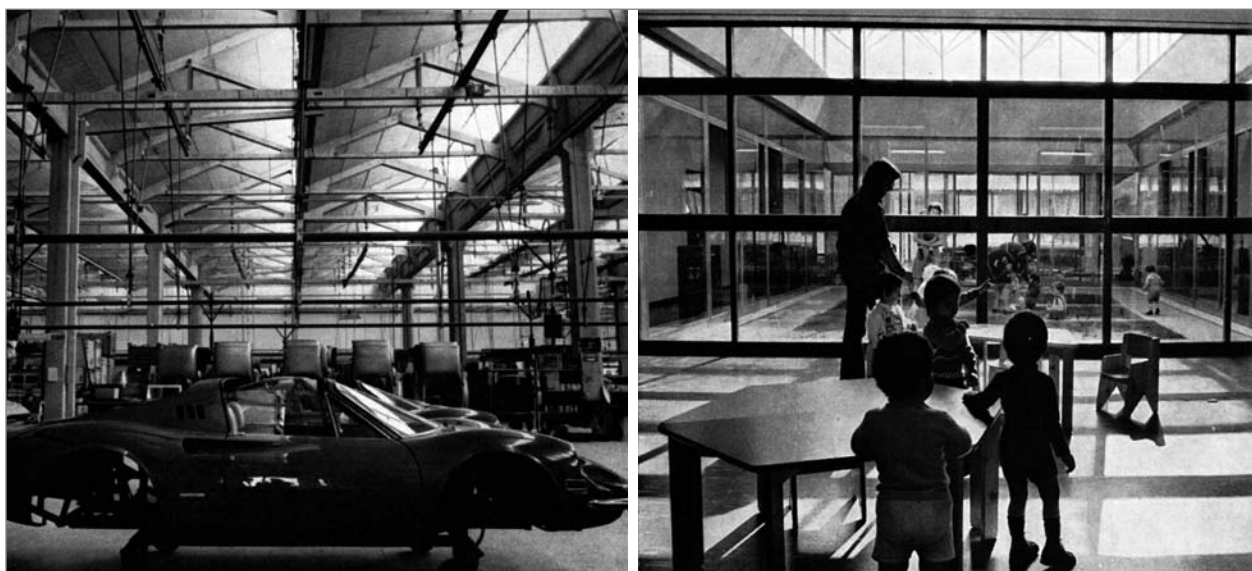
[Fig. 23] Sistemi costruttivi prefabbricati impiegati per la realizzazione di edifici industriali, così come per l'edilizia scolastica: (a sinistra) interno di una fabbrica automobilistica, caratterizzata da un sistema di pilastri prefabbricati, sui quali poggia la struttura a shed composta da travi reticolari a denti di sega, montata su travi principali ad anima piena (sistema RDB); (a destra) interno di una scuola materna, caratterizzata da una struttura organizzata su tre assi spaziali, in cui la direzione verticale è assunta da un montante e le due direzioni orizzontali da una trave e dal solaio, a scandire la distribuzione degli spazi architettonici che prendono luce da ampie vetrate modulari laterali e da shed in copertura.
