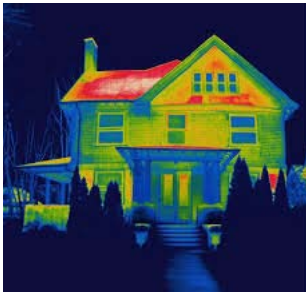
Figura 16: Immagine termografica di un edificio, per la valutazione della dispersione termica (15).
