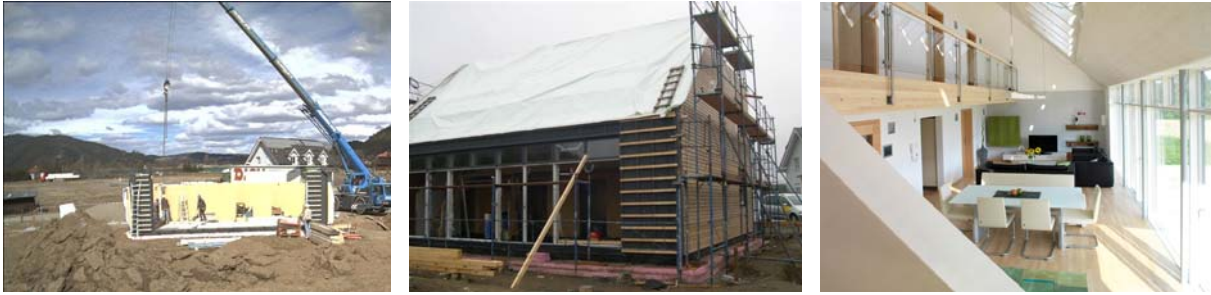
Foto di cantiere con in evidenza la fase di montaggio della struttura portante a pannelli lignei prefabbricati (fig. 3.30); della fase avanzata poco prima del fissaggio del rivestimento a doghe (fig. 3.31); vista sulla zona giorno con in evidenza il doppio volume generato dalla falda di captazione a forte pendenza (fig. 3.32)
