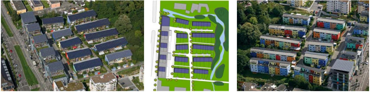
Complesso Am Schlierberg: vista aerea da sud-ovest (fig. 3.2, sulla sinistra il Sonnenschiff); schema d'impianto urbano con la suddivisione dei lotti (fig. 3.3); vista aerea da nord-ovest (fig. 3.4)
