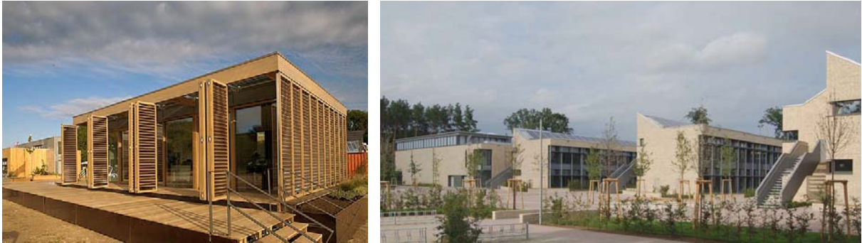
surPLUShome, prototipo dell'Università Tecnica di Darmstadt, vincitore dell'edizione 2007 del Solar Decathlon (fig. 2.11); Plus Energy primary school, (IBUS, 2011) a Hohen Neuendorf, Germania (fig. 2.12)
