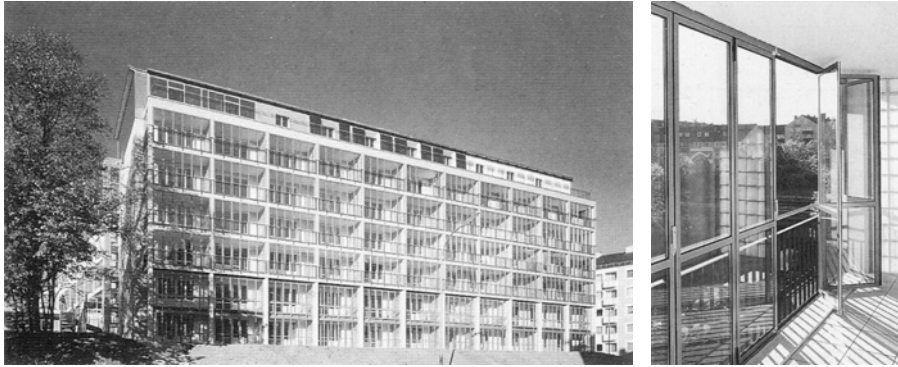
Esempio di sistema a serre solari in facciata sud (fig. 4.114); dettaglio del sistema di apertura a libro degli infissi di una delle serre (fig. 4.115)
