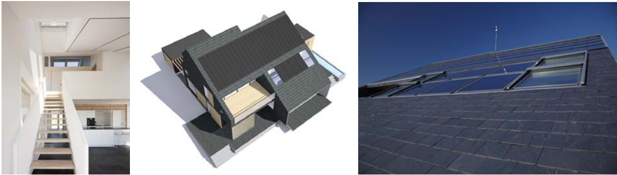
Vista sulla scala a giorno (fig. 3.18), modello tridimensionale (fig. 3.19) e dettaglio della copertura con in evidenza l'integrazione tra i sistemi di captazione e il manto di copertura (fig. 3.20)
