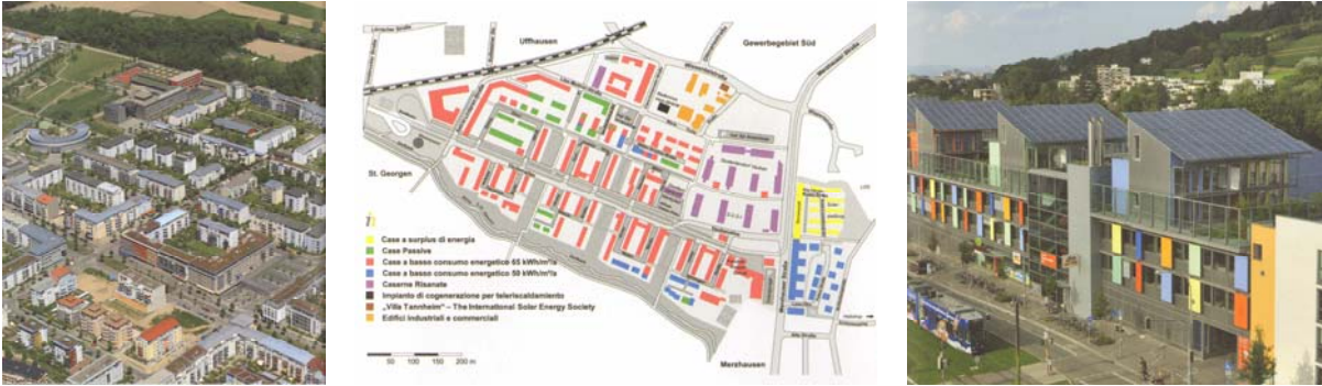
Quartiere Rieselfeld: vista dall'alto (fig. 1.04); quartiere Vauban: zonizzazione in base alle prestazioni degli edifici (fig. 1.05); edificio Sonnenschiff: vista sud-ovest (fig. 1.06)
