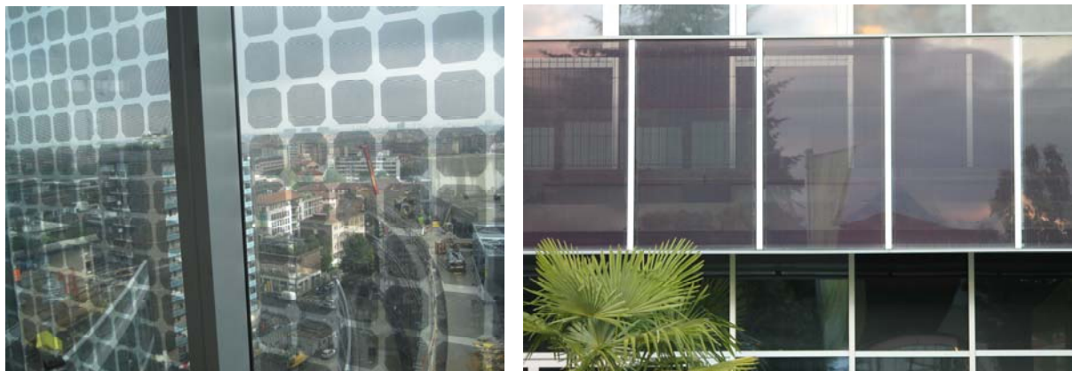
Fig. 2.52. Nuova sede della Regione Lombardia, Milano (Pei Cobb Freed & Partners, 2011): dettaglio della vetratura a celle FV semitrasparenti; fig. 2.53 Enzian tower, Bolzano (Z. Bampi, 2010): dettaglio dei parapetti attivi con interposto un film sottile semitrasparente
