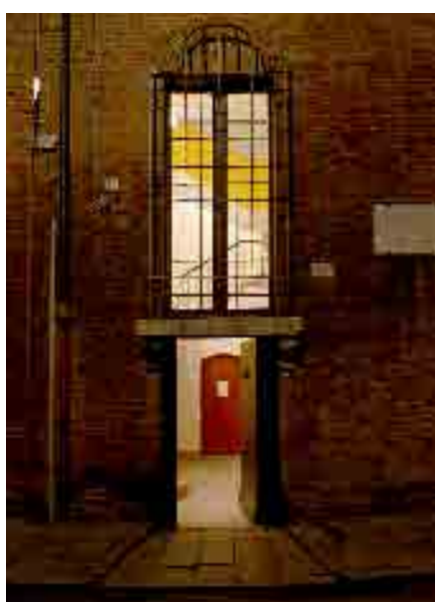
Figure 16-19. A fianco: I due vani scala progettati lungo vicolo del Granchio (a sinistra) e via Giuoco del Pallone; Nella pagina a fianco: P. Bottoni, Planimetrie della sistemazione di casa degli Ariosti con evidenziate le demolizioni e le parti nuove (1954); Nel disporre i rinnovati spazi interni Bottoni non mutò la fisionomia delle facciate della casa. I suoi interventi, evidenti soprattutto nella definizione dei vani scala sono fortemente connotati dall'uso del colore.
