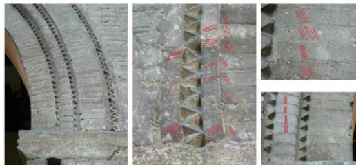
Fig. 5.13 Portale di Casa Isolani, Bologna. Risultati delle osservazioni de visu. La lavorazione a denti di sega evidenzia triangoli diversi tra di loro prova di una probabile produzione in opera. Si noti anche l'effetto 'scultoreo' conseguito attraverso la rigatura dei mattoni che compongono la ghiera dell'arco. Questa finitura sottolinea come il laterizio a Bologna fosse utilizzato alla stregua di una pietra artificiale sia sotto il profilo estetico sia dal punto di vista delle tecniche di lavorazione connotando la facciata con quel carattere di monoliticità e vibrazione tipico del materiale lapideo.
