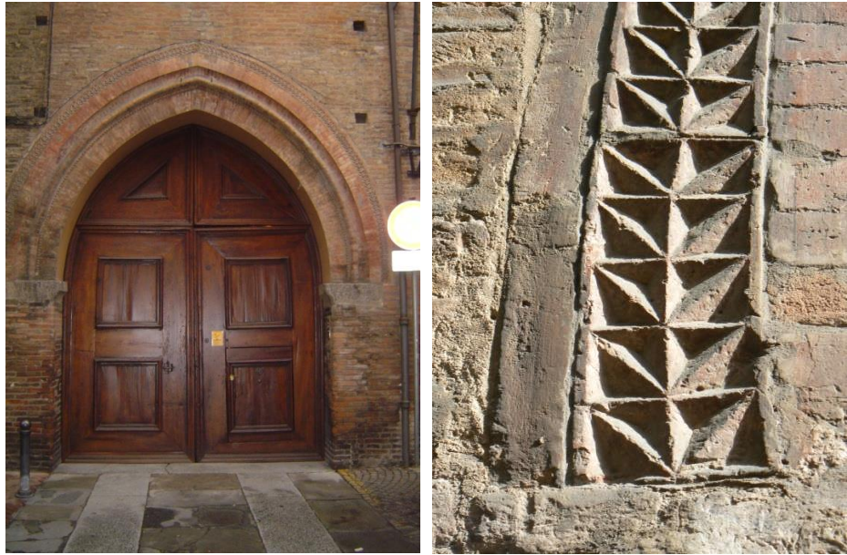
Fig. 6.5 Portale in cotto a sesto acuto con cordoni di casa Grassi (XIII secolo), via Marsala, 12. La ghiera è composta da due file di mattoni scalati e divisi da una risega sagomata a ovolo e decorata con denti di sega. La parte esterna della doppia ghiera è incavata a gola. Il bardellone è costituito da una larga fascia laterizia ornata a triangoli raddoppiati.
