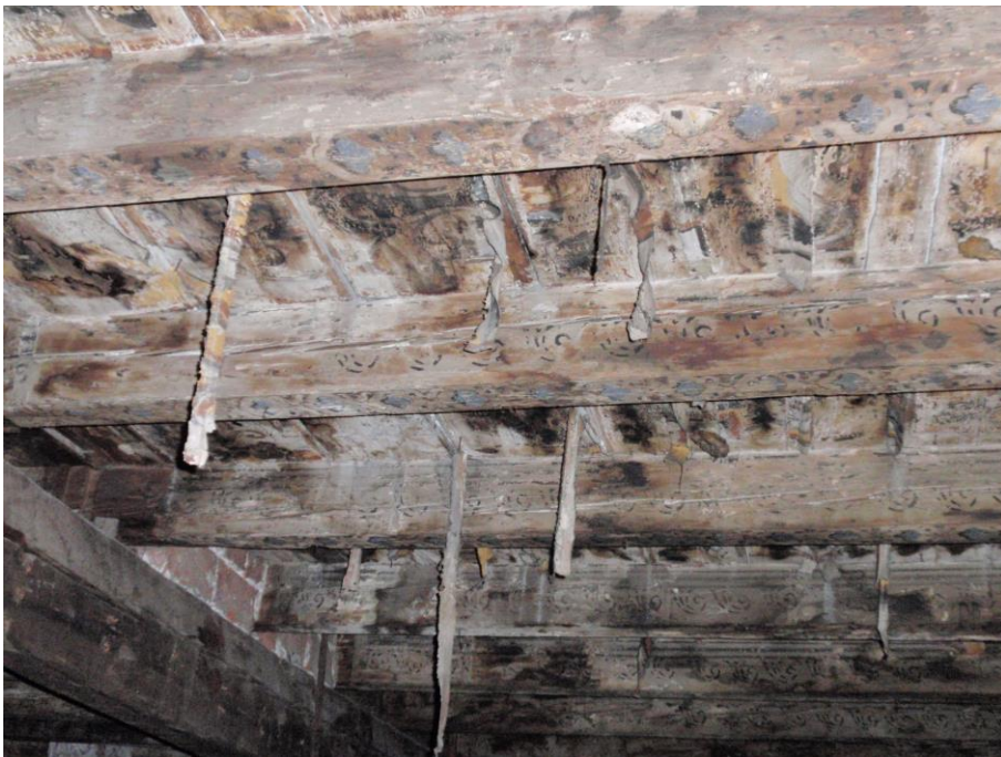
Fig. 4.18 Palazzo Sanguinetti, Strada Maggiore, 34. Intradosso del solaio-sottotetto cinquecentesco conservato al di sopra della volta di cannicciato con centine lignee di fine Settecento. Gli asenari costituiscono le catene delle capriate (immagine in alto) su cui poggia l'orditura secondaria dei quaderletti. Da notare il sistema di chiusura improprio dello spazio tra quaderletto e asenaro costituito da laterizi apparecchiati in foglio che, originariamente, sarebbe dovuto essere composto da bussole lignee o tavole disposte verticalmente, e le strisce in tessuto pendenti, presumibilmente di canapa o lino, che celavano i giunti dell'assito ligneo consentendo l'ottenimento di un intradosso continuo utilizzato come supporto per l'apparato decorativo.
