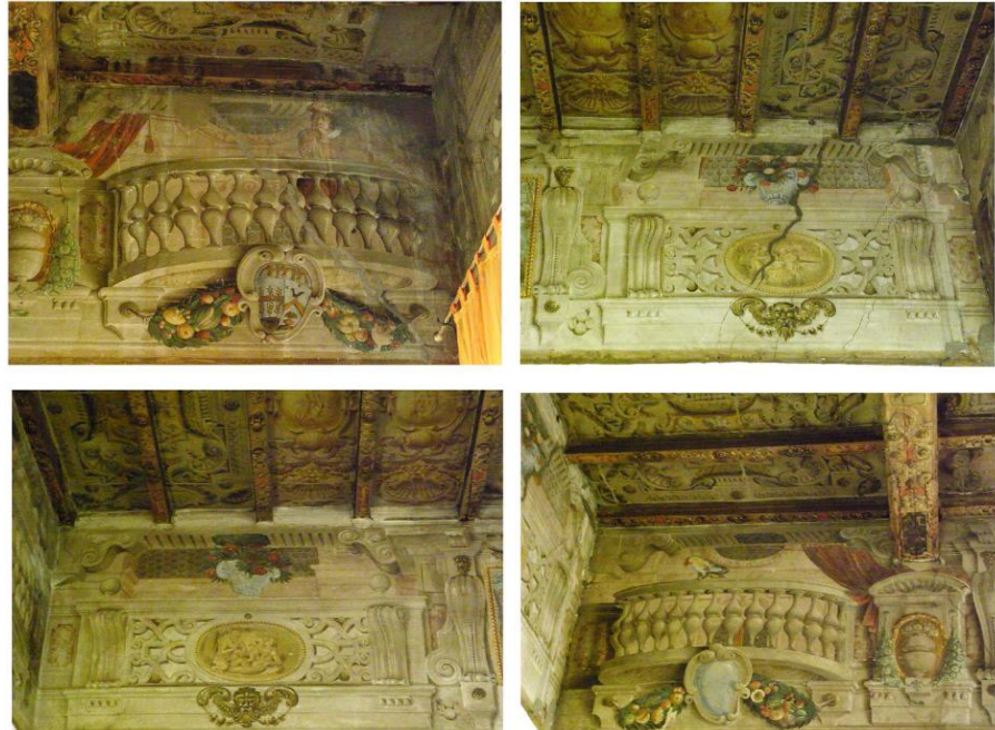
Fig. 4.31 Palazzo di via San Felice, 65. Riquadri del fregio pittorico ispirato dalla scuola dei quadraturisti. Da notare come le prospettive delle finte architetture si interfaccino con il sistema costruttivo composto da asenari e quaderletti, anch'essi dipinti.
