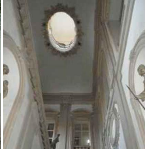
Fig. 7.2 Palazzo Fantuzzi, via San Vitale, 23. Volta a schifo in camoranna con oculo ellittico dello scalone risalente al 1680 c. ad opera di Paolo Canali.
