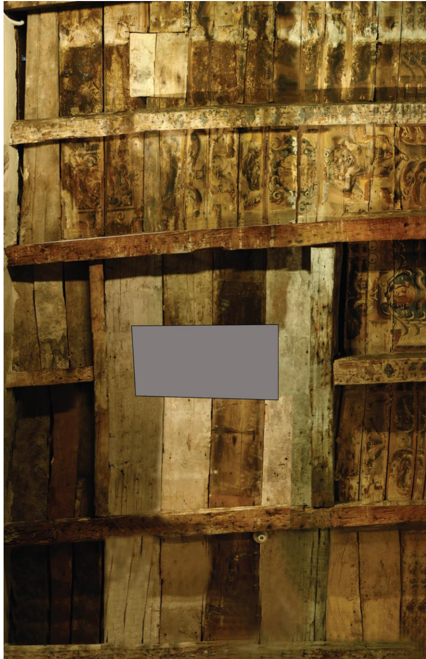
Fig. 4.19 Palazzo Sanguinetti, Strada Maggiore, 34. Fotorestituzione dell'intradosso del solaio ligneo cinquecentesco ora nascosto. Il solaio, dipinto probabilmente da Giovan Battista Cremonini (1550-1610) nel 1569 su incarico di Ervole Riario il quale commissionò anche l'affresco del fregio con le Storie di Caterina Sforza e Girolamo Riario. Il solaio ligneo era costituito dalle capriate del tetto e copriva un grande salone. Quest'ultimo fu suddiviso in due stanze nel 1795 durante il riordino del palazzo ad opera di Giovan Battista Martinetti (1774-1830) il quale nascose il soffitto dipinto con una volta di cannocciato.
