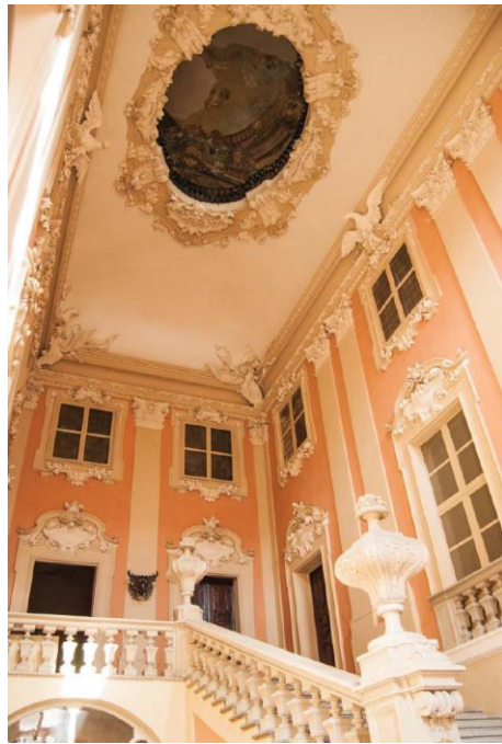
7.9 Palazzo Aldrovandi Montanari, via Galliera, 8. Scalone monumentale risalente al 1741 c. opera di Alfonso Torreggiani.
