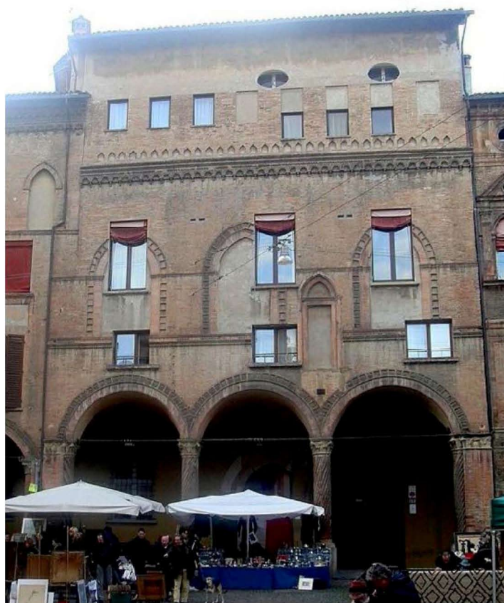
Facciata di Casa Bovi Tacconi
