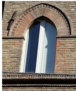
Finestra medievale di Casa Grassi, via Marsala 12 (XIII secolo); ghiera costituita da mattoni posti di fascia e da formelle recanti un motivo a quadrifoglio
