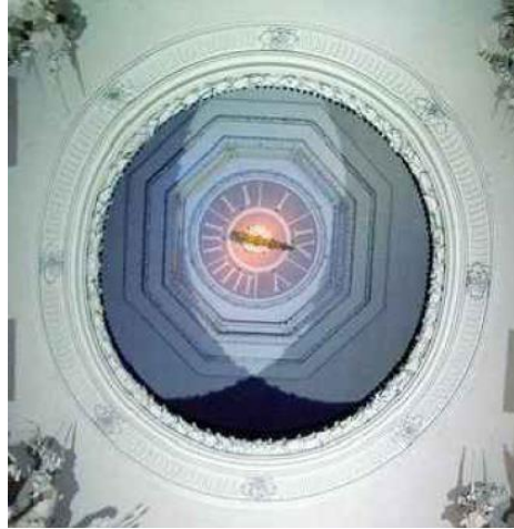
Fig. 7.1 Palazzo Albergati, via Angelo Masini, 46 (Zola Predosa). Volta a padiglione in muratura con oculo circolare del salone d'onore risalente al 1659 ad opera di Gian Giacomo Monti.
