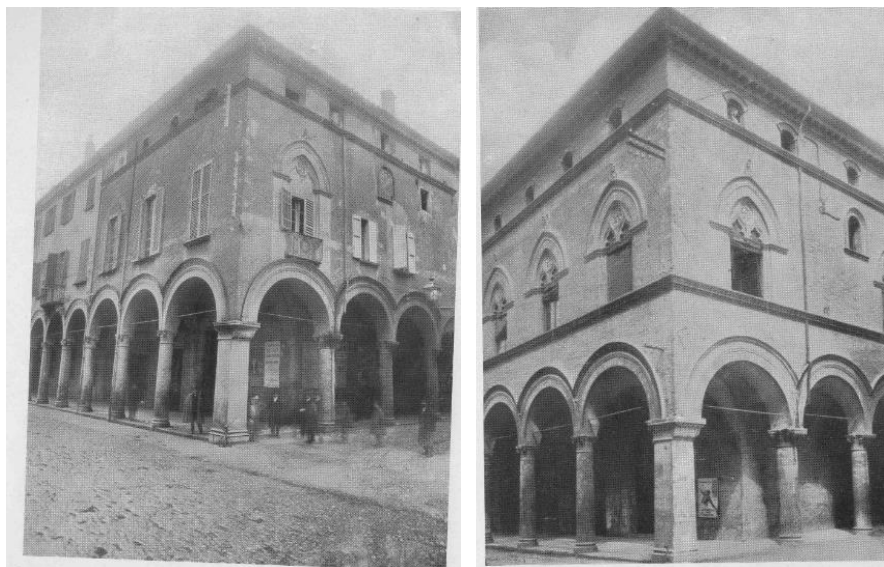
Fig. 5.6 Casa Bertani via Galliera, 13. La casa edificata nel secondo Quattrocento conservava solo una finestra in terracotta in stile gotico di transizione. Nel 1906 il Comitato per Bologna storico e artistica provvide a “consolidare le colonne, completare le decorazioni di cotto delle finestre, arricchire la porta con valve e picchiotto d’imitazione quattrocentesca”. Immagini tratte da G. ZUCCHINI, a cura di, L’opera del Comitato per Bologna storico e artistica , op. cit., pp. 30-31.
