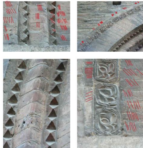
Dettagli delle lavorazioni superficiali e delle decorazioni del portale di casa Rodondi
