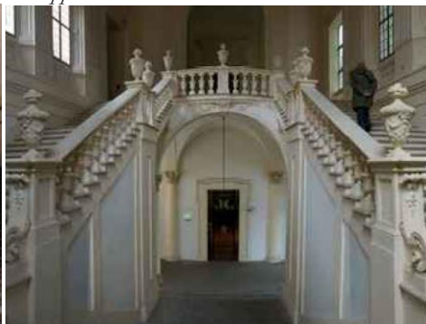
Fig. 7.8 Palazzo Davia – Bargellini, strada Maggiore, 44. Scalone monumentale settecentesco opera di Alfonso Torregiani.
