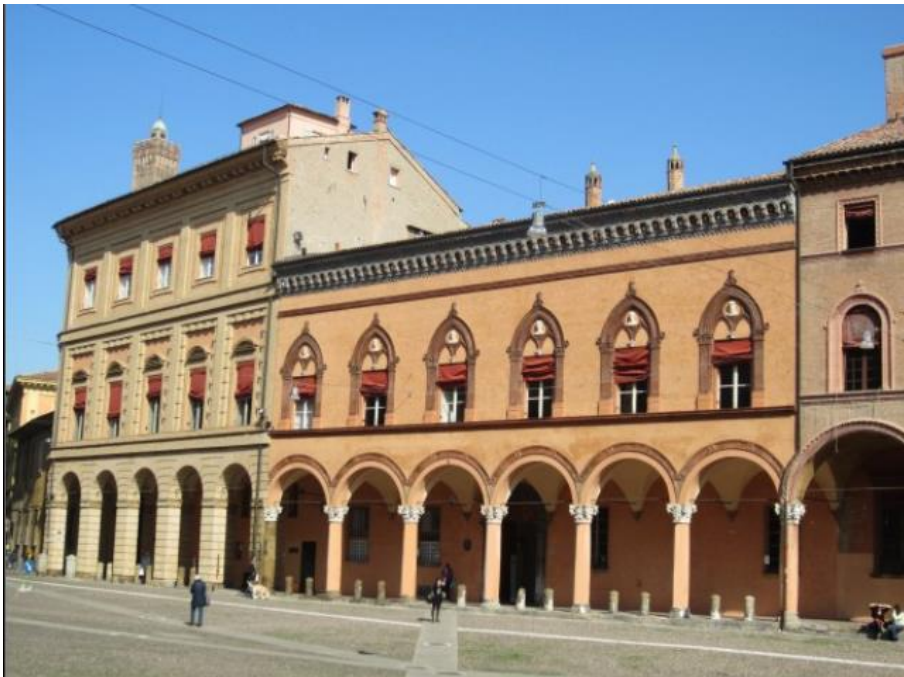
Fig. 5.40 Palazzo Isolani, Piazza Santo Stefano, 16-18. La facciata prima e dopo i restauri del 2011.
