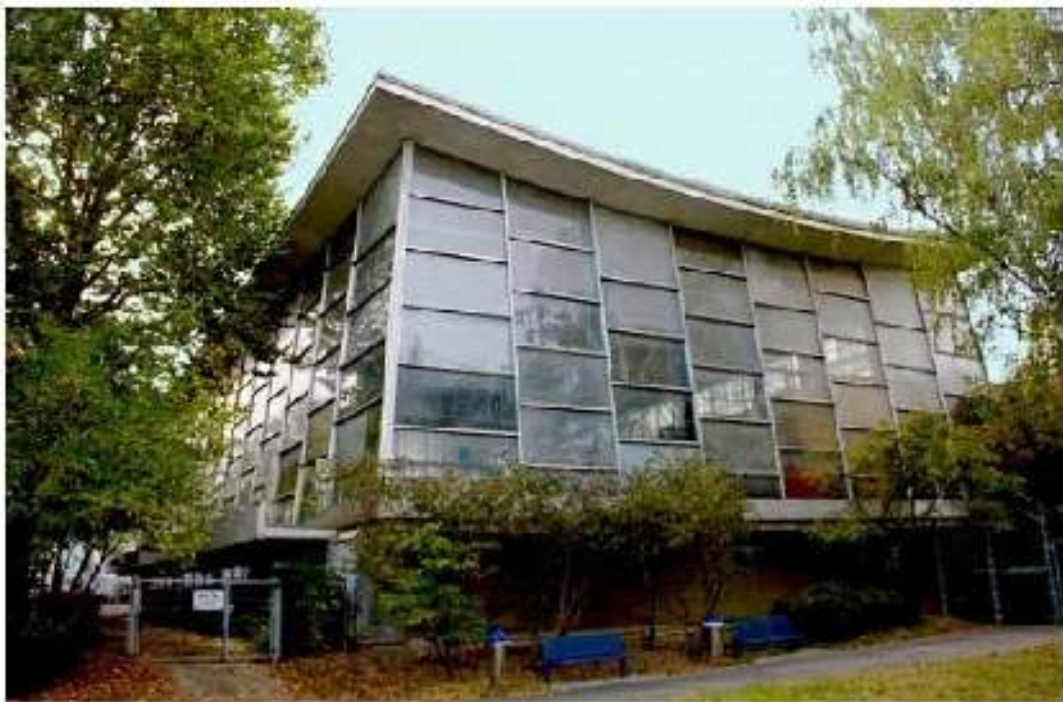
M. Lehmbruck _ Stadtbad , Stuttgart-Feuerbach (1952/1961).
