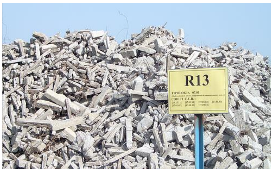
Figura 1.5: Rifiuti da costruzione e demolizione.
