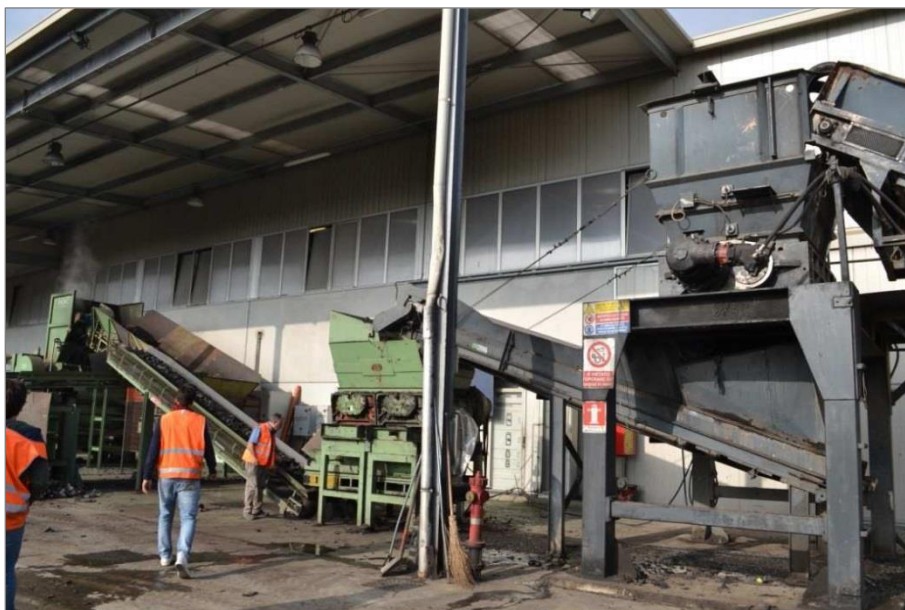
Figura 4.2: Impianto di triturazione degli pneumatici.
