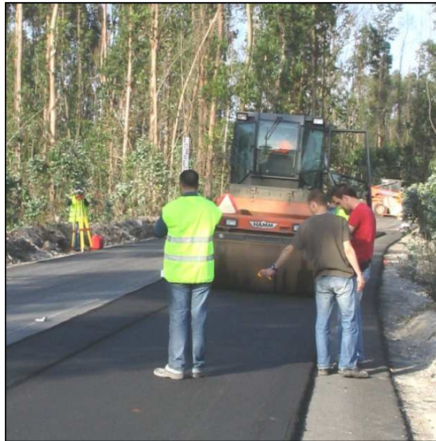
FIGURA5.37: COMPATTAZIONE IN SITO.
