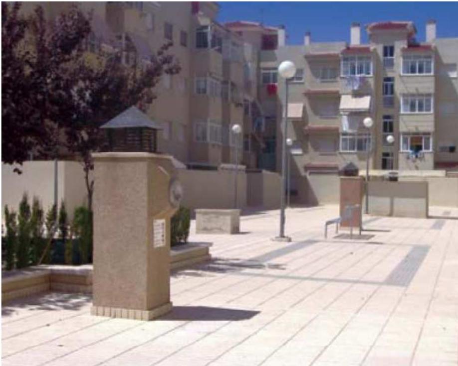
Figura 8.6. Colonne di raccolta in un quartiere residenziale svedese.
