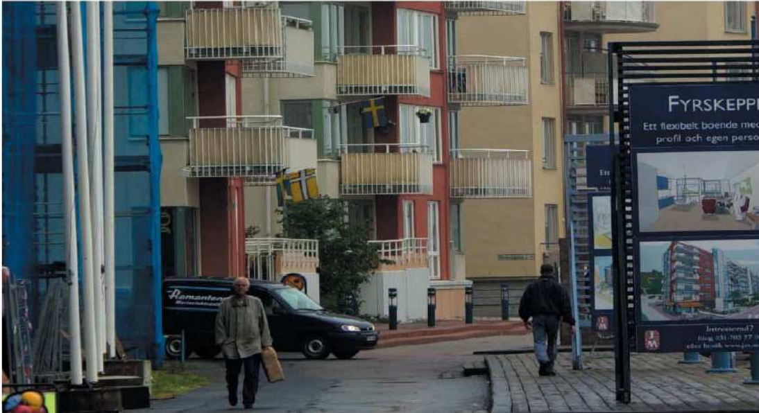
Figura 7.4: Vista su un edificio servito dalla raccolta pneumatica
