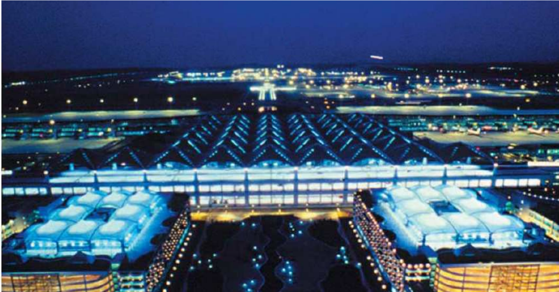
Figura 7.38. Vista sui terminal dello scalo internazionale dell'aeroporto di Kuala Lumpur.
