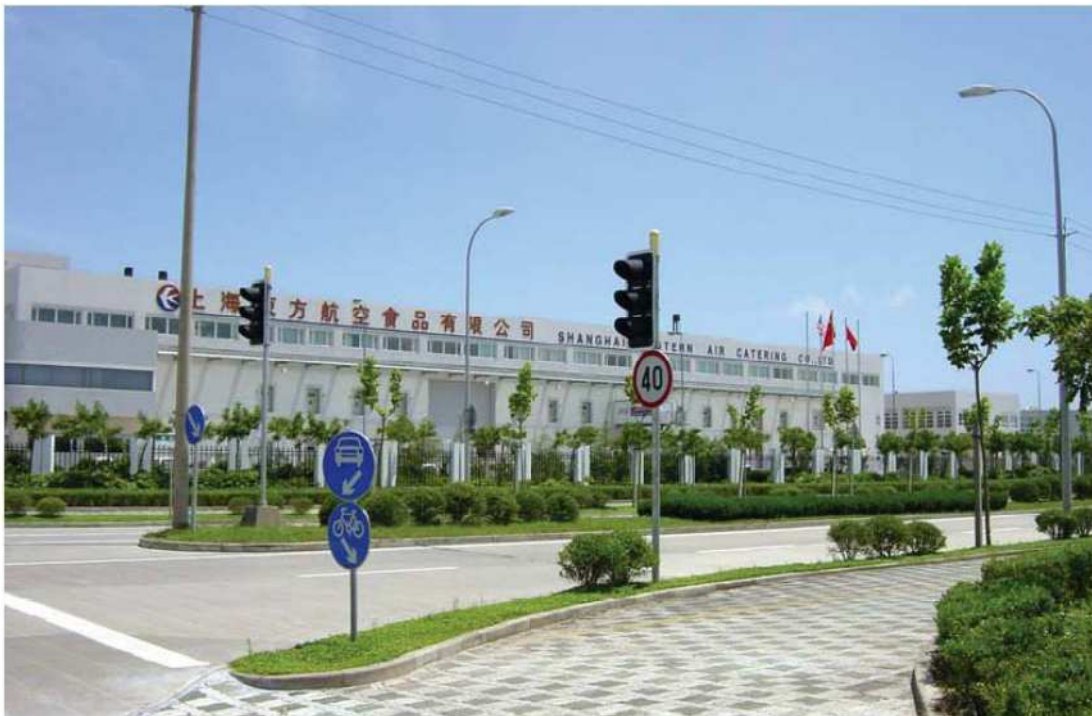
Figura 7.39. Centro di servizio catering dell'Aeroporto Pudong di Shangai
