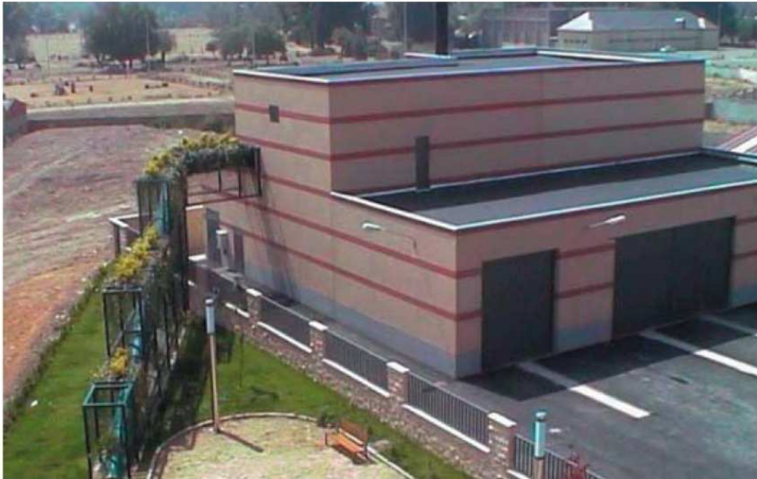
Figura 7.31. Stazione di raccolta dei rifiuti a Leon.
