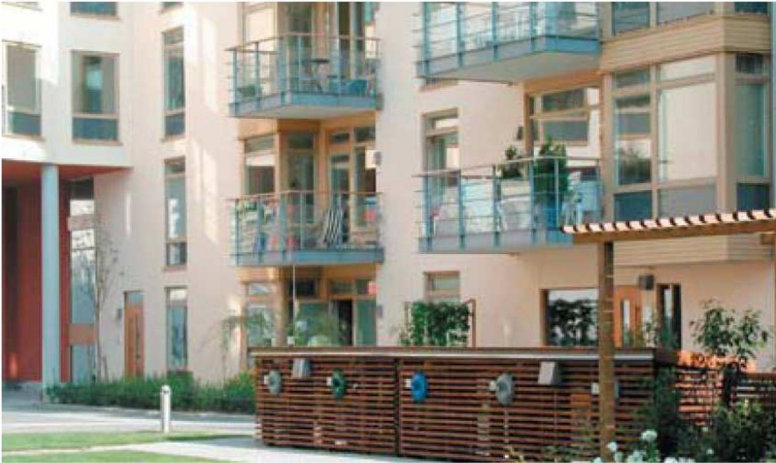
Figura 7.5: Vista su un cortile interno di un edificio dotato di colonnine di raccolta per il sistema pneumatico mobile.
