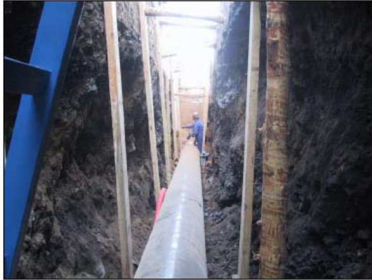
Figura 6.11. Posa delle reti di condotte sotterranee
