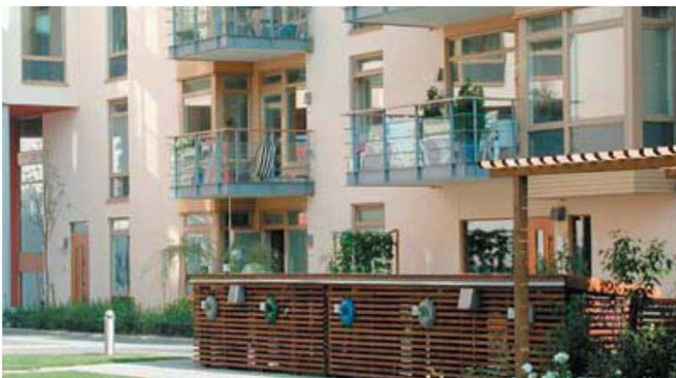
Figura 8.8. Vista sul cortile interno di un condominio. I contenitori sono schermati da un setto ligneo che ne fa percepire la presenza ma ne mitiga l'impatto sulla strada. I colori differenti dei chiusini facilitano l'utente nella scelta del contenitore appropriato.
