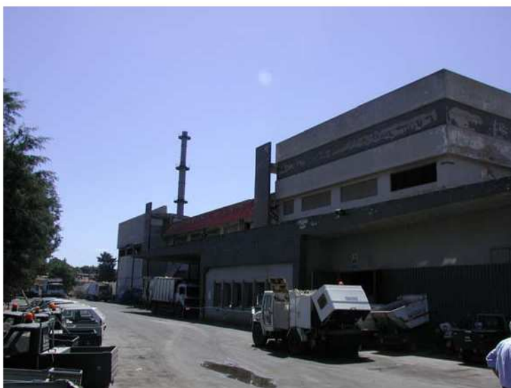
Figura 11.1: Stazione di raccolta dei rifiuti presso la località di Caniga, Sa
