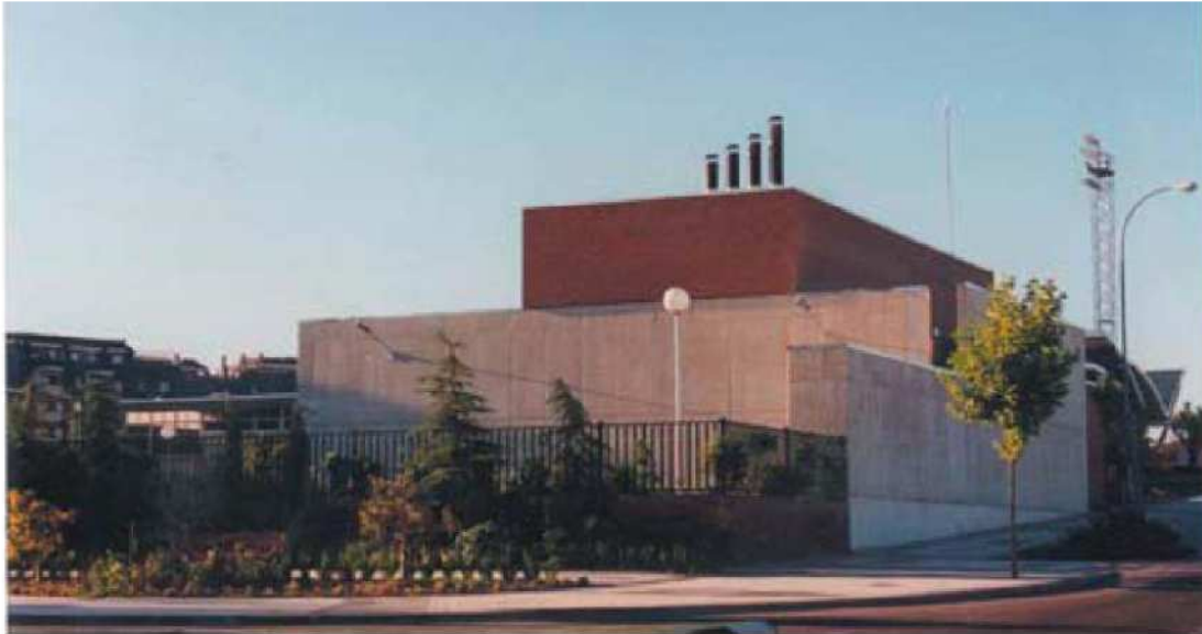
Figura 7.17. Stazione di raccolta dei rifiuti di Arcipreste.
