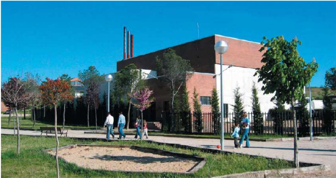
Figura 7.25. Stazione di raccolta dei rifiuti a Majadahonda.
