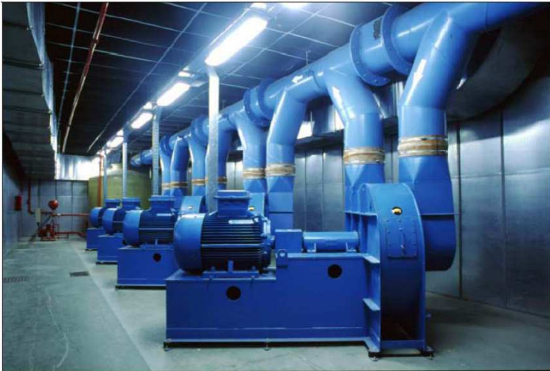
Figura 6.2. Turboestrattori all'interno della centrale di raccolta.
