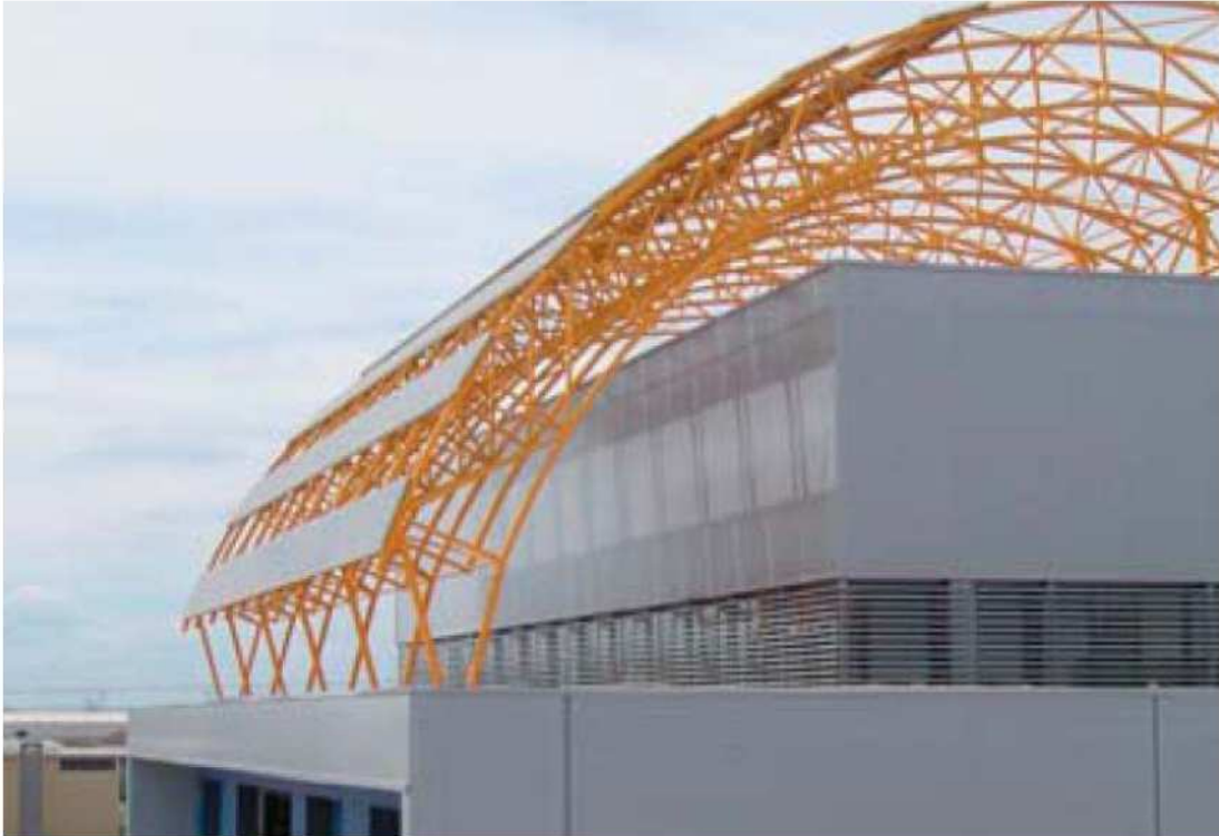
Figura 7.9: Stazione di raccolta dei rifiuti per la seconda fase del progetto.
