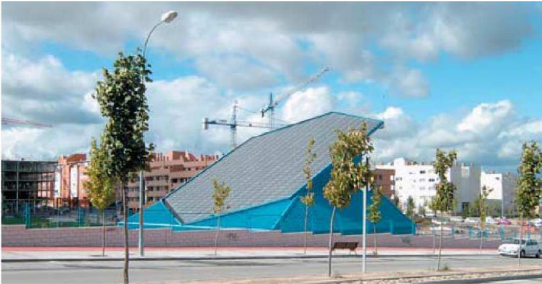
Figura 7.14: Stazione di raccolta dei rifiuti a pannelli solari a Vadelasfuentes
