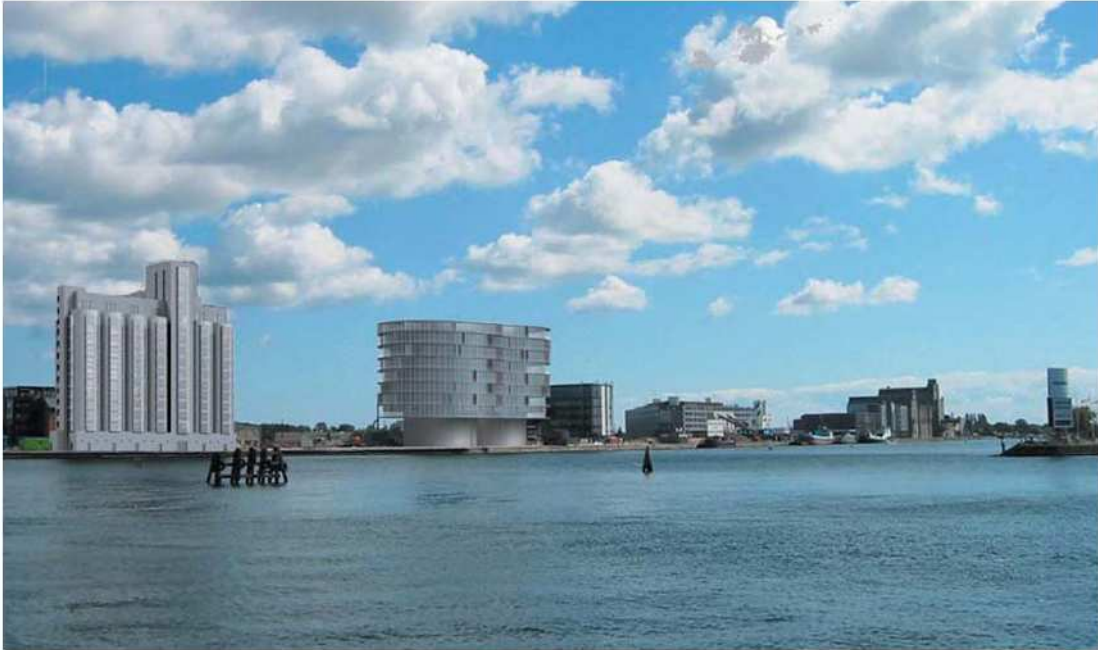
Figura 7.34. Vista dal mare sul nuovo quartiere di Havnestad.
