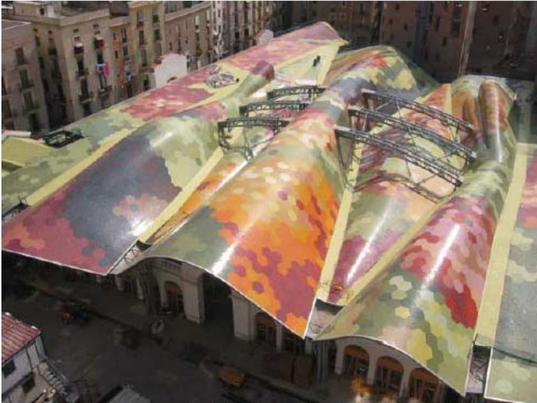
Figura 7.30: Vista del mercato di S. Caterina, ristrutturato dallo studio Miralles-Tagliabue. Al di sotto si trova la centrale di raccolta.
