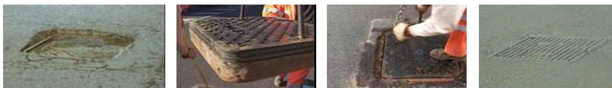
Figura 4.74 – Installazione di pannelli di livellamento [173]
