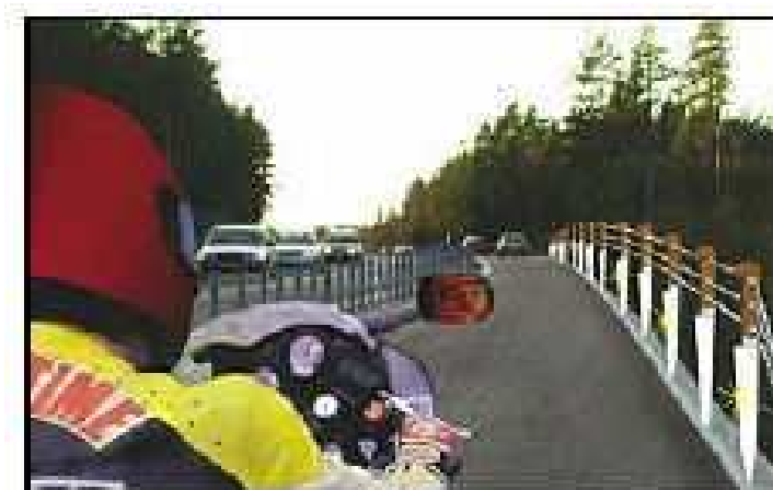
Figura 4.49 - Montanti stradali visti dal punto di vista dei motociclisti.
