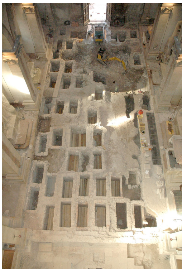
. Fig. 30: il cimitero tardo rinascimentale all'inizio della demolizione.
