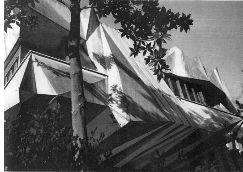
Particolare del piano superiore
