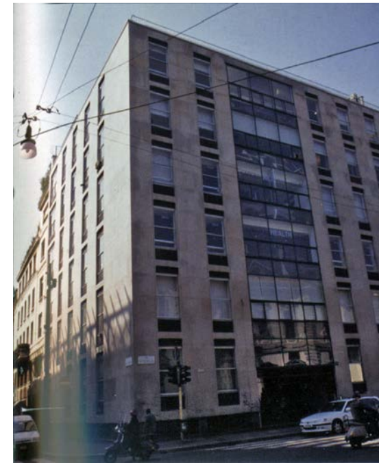
M. Zanuso, R. Menghi con Lucio Fontana – edificio per uffici, 1947, via Senato 11, Milano – foto Michela Formenti
