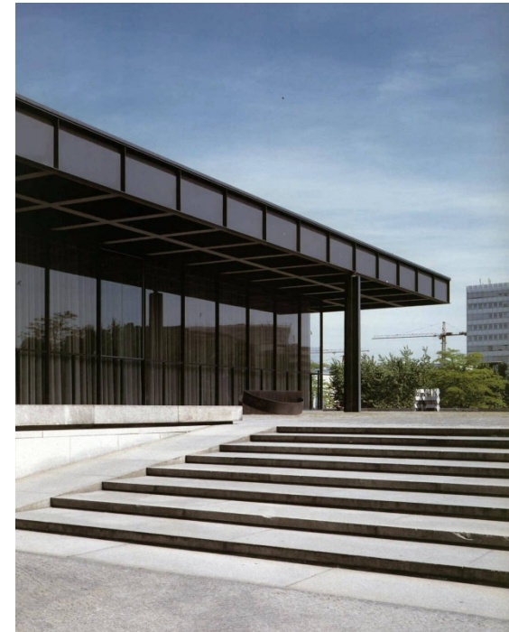
Ludwig Mies Van der Rohe Neue nationalgalerie 1968 Mies van der rohe Editorial Gustavo Gili, Barcelona 2001
