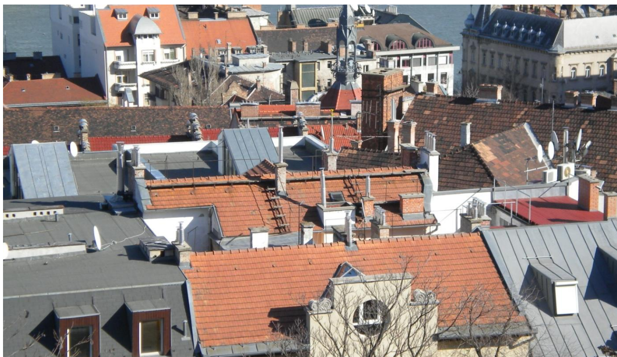
Fig. 3.13 – Molteplicità di materiali e orientamenti nelle coperture
