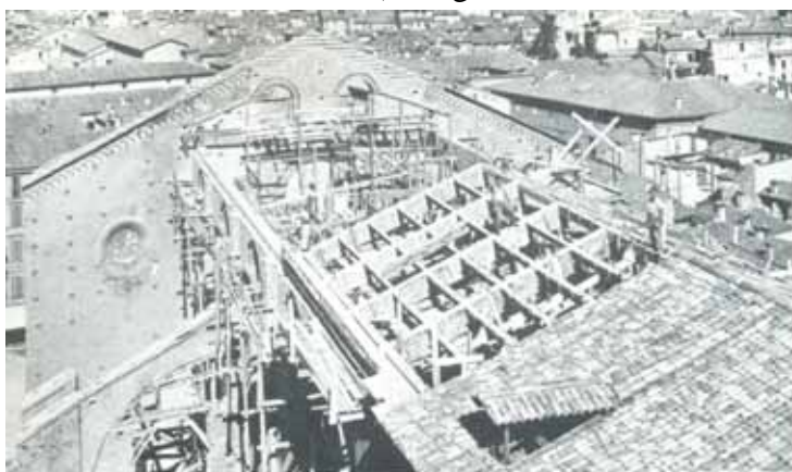
Basilica di San Francesco il consolidamento e la ricostruzione del tetto (Bologna, S.B.A.P.B., Archivio fotografico)
