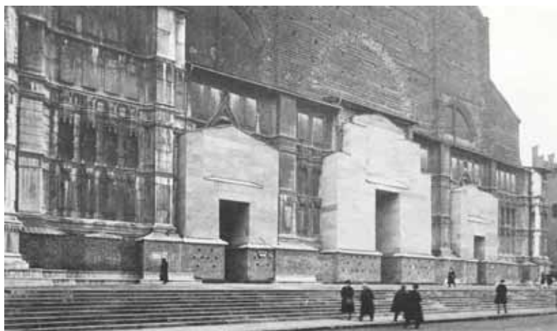
Basilica di San Petronio. Opere protettive dei tre portali e del basamento. (Bologna, S.B.A.P.B., Archivio fotografico)
