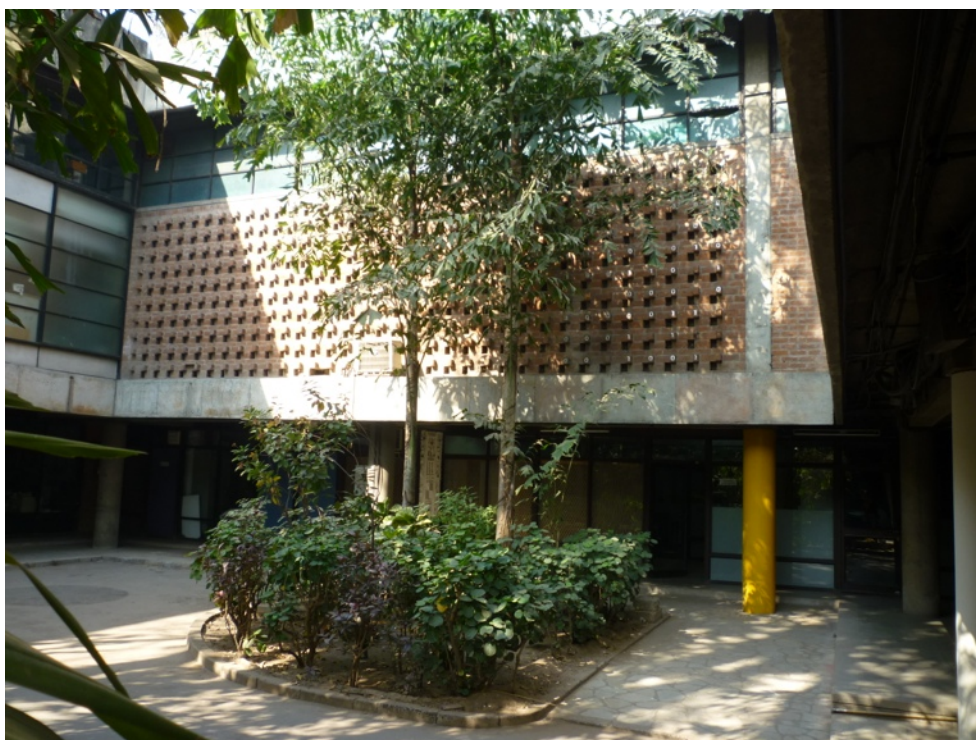
XVII: Vista della corte verso i locali tecnici del primo piano
