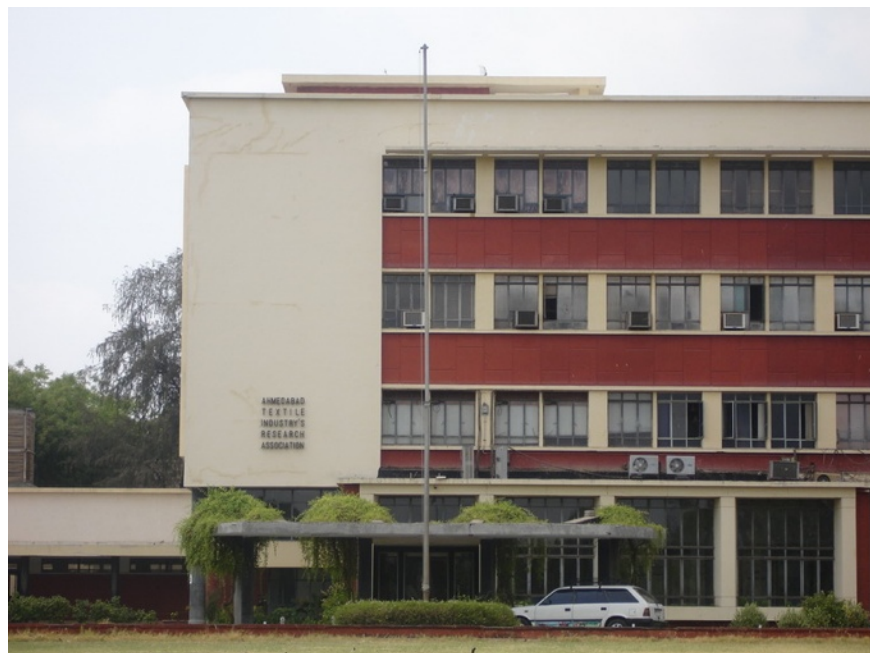
Fig. 51. Dettaglio del prospetto nord
