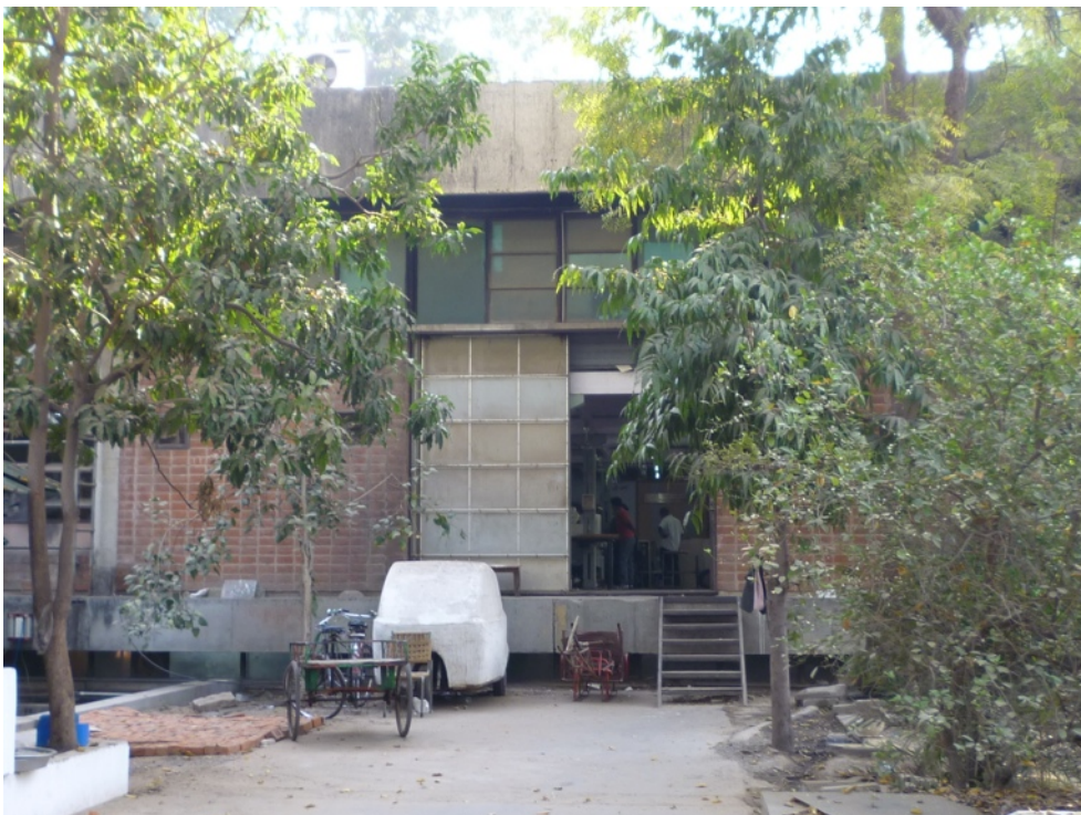
V: Prospetto ovest, porzione
