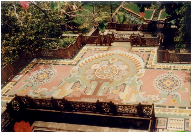
Fig. 39. Dettaglio della pavimentazione in mosaico
