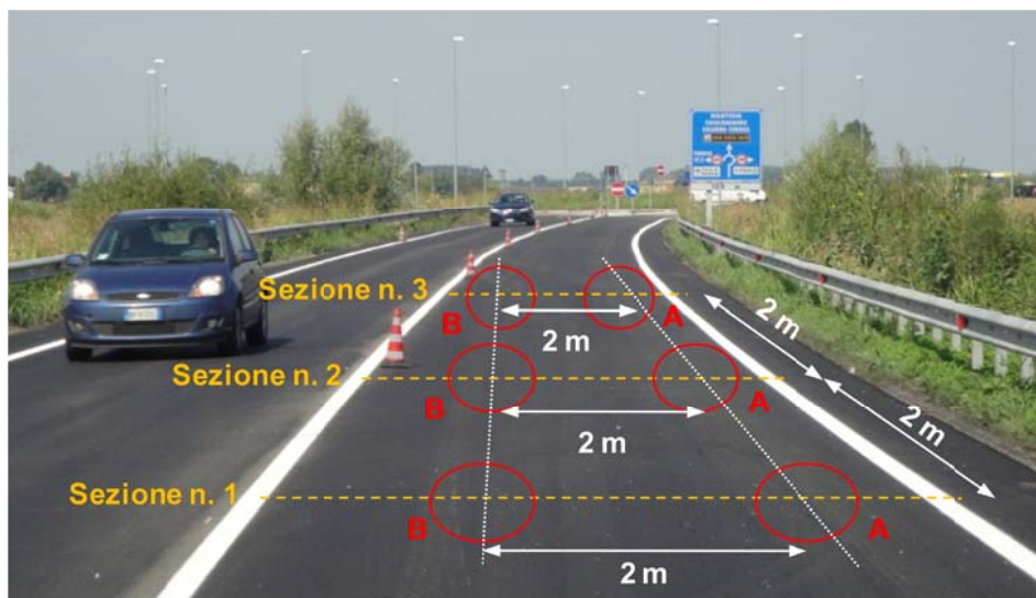
Figura 5.15 Sperimentazione in sito su 3 sezioni stradali.
