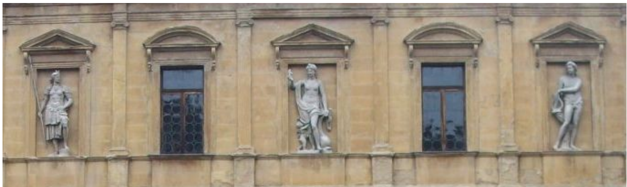
Figura 6: Loggia Cornaro Padova
