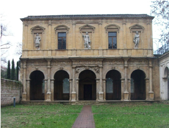
Figura 9: Loggia Cornaro, Padova
