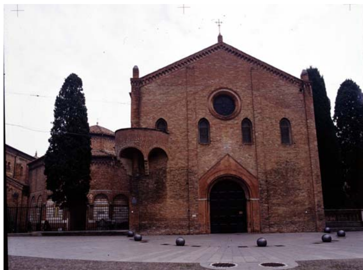
Figura 1.3-5 La facciata della Chiesa di Santo Stefano.
