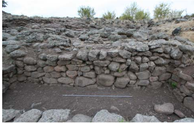
Figura 6.4.2-1 Il muro sottoposto a sperimentazione.
