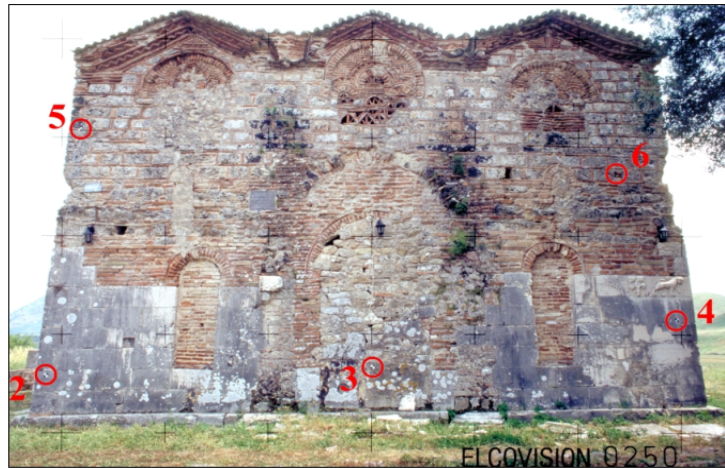
Figura 5.3-3 La facciata ovest del monastero con i punti d'appoggio utilizzati per il raddrizzamento.
