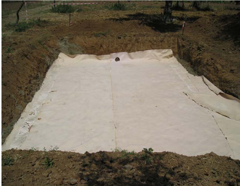
Figura 6.3 - Il posizionamento del telo in materiale non alterabile per evitare fenomeni di alterazione direttamente al contatto con il terreno.
