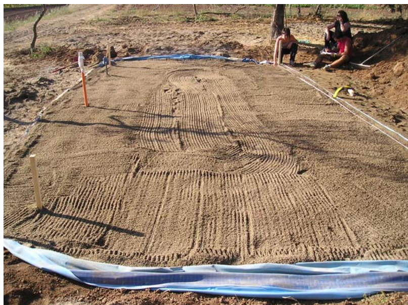
Figura 6.7 - Riempimento dell'intero settore con materiale sabbioso fino alla quota del piano campagna.
