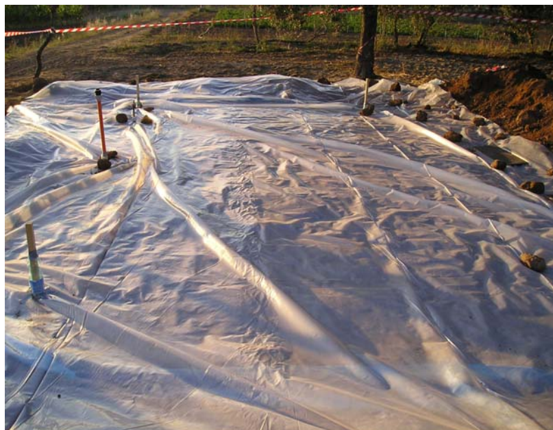
Figura 6.10 - Copertura del settore con materiale impermeabile per evitare infiltrazioni di acqua meteorica e preservare il contenuto idrico del corpo sabbioso.
