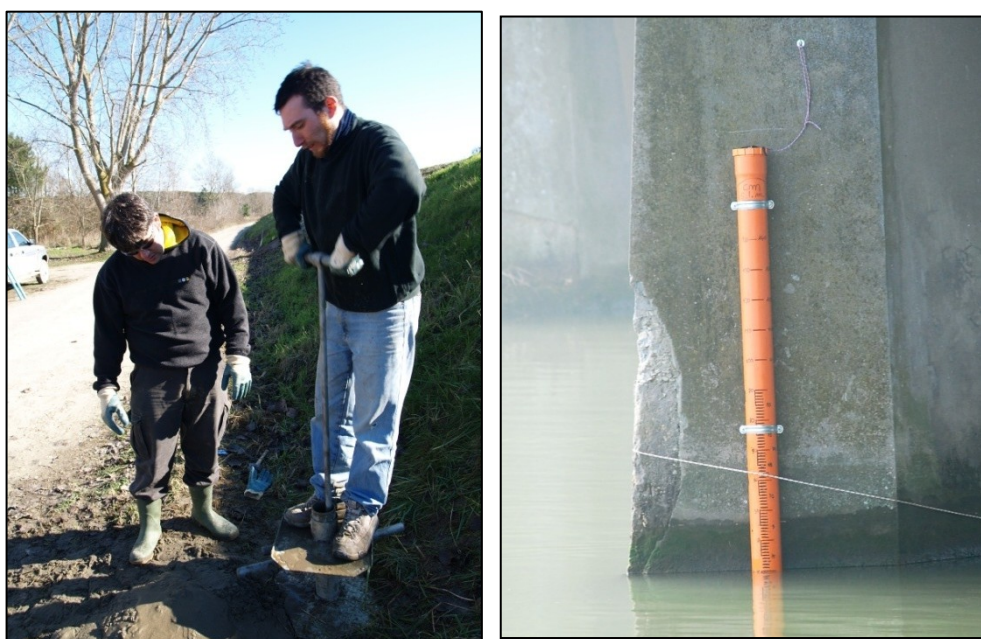
Fig. 66: Installazione manuale della rete piezometrica (a sinistra) e supporto per la misura di dati in continuo sul Lamone (destra).
