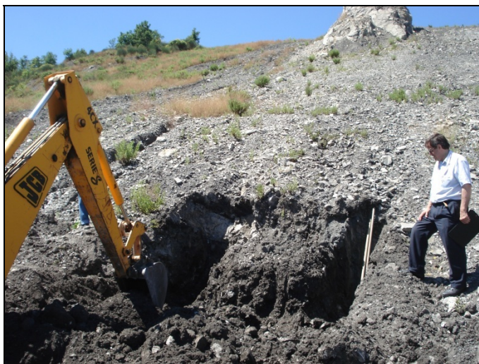
Figura 5.14 Scavo delle trincee laterali.
