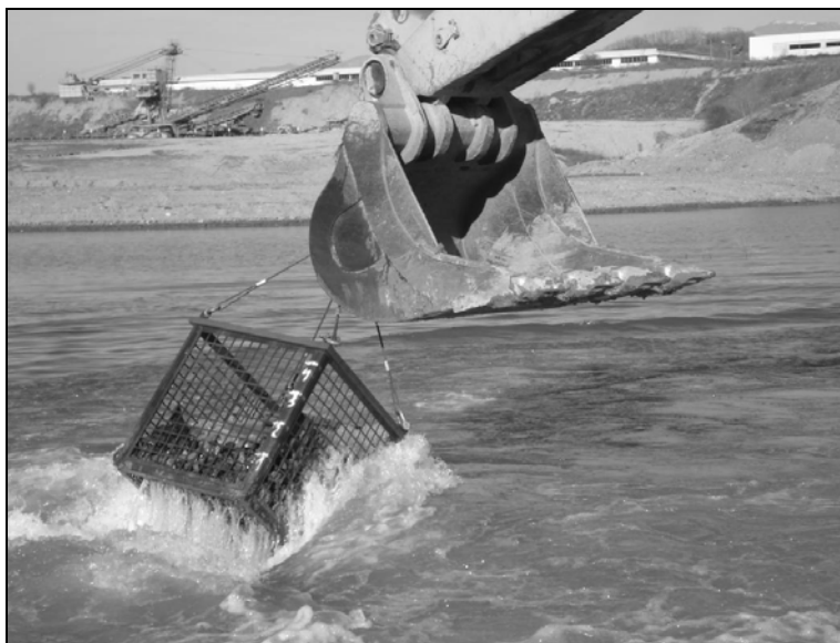
Figura 5.32 Dilavamento del vaglio per la rimozione del materiale con dimensioni inferiori alla soglia blocchi-matrice (1 cm).
