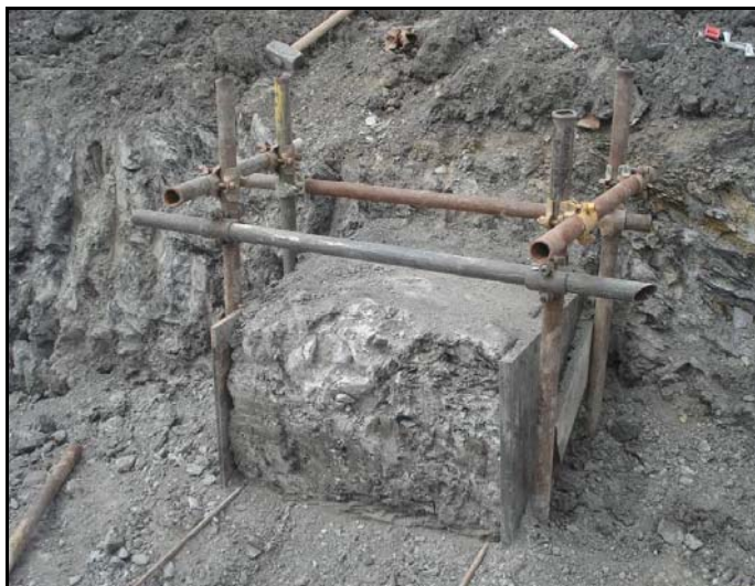
Figura 5.16 Posizionamento delle piastre laterali e dell'intelaiatura rigida.
