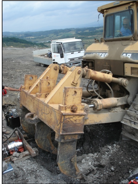
Figura 5.19 Posizionamento del Caterpillar D8 come mezzo di contrasto per la spinta del pistone. Il ripper del dozer è portato a contrasto con una trave di ferro posta in posizione orizzontale posteriormente alla piastra di supporto ad L.
