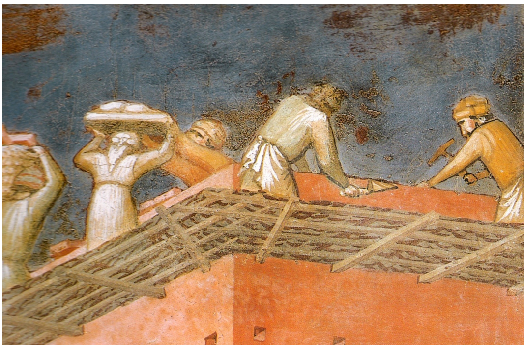
Fig. 21. Ambrogio Lorenzetti, Effetti del Buon Governo in città , 1337-1340, Sala della Pace, Palazzo Pubblico, Siena, particolare. Muratori e manovali al lavoro sull'impalcatura di un cantiere cittadino.
