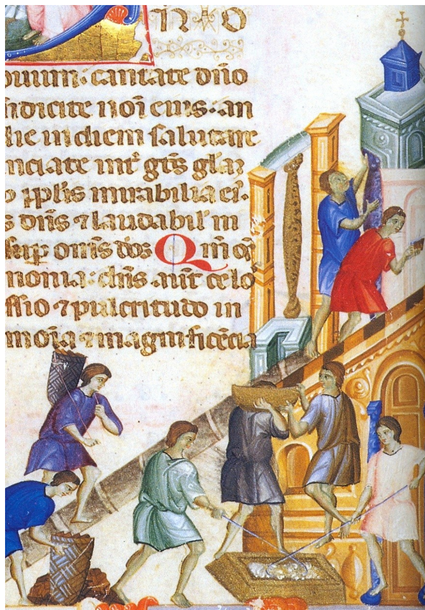
Fig. 12. Bologna, Biblioteca Universitaria, ms. 346: Psalterium innario, con calendario ed elementi dell'ufficiatura , 1285-1290 ('Maestro della Bibbia di Gerona'), particolare. Rappresentazione di un cantiere con maestri, apprendisti e manovali all'opera.
