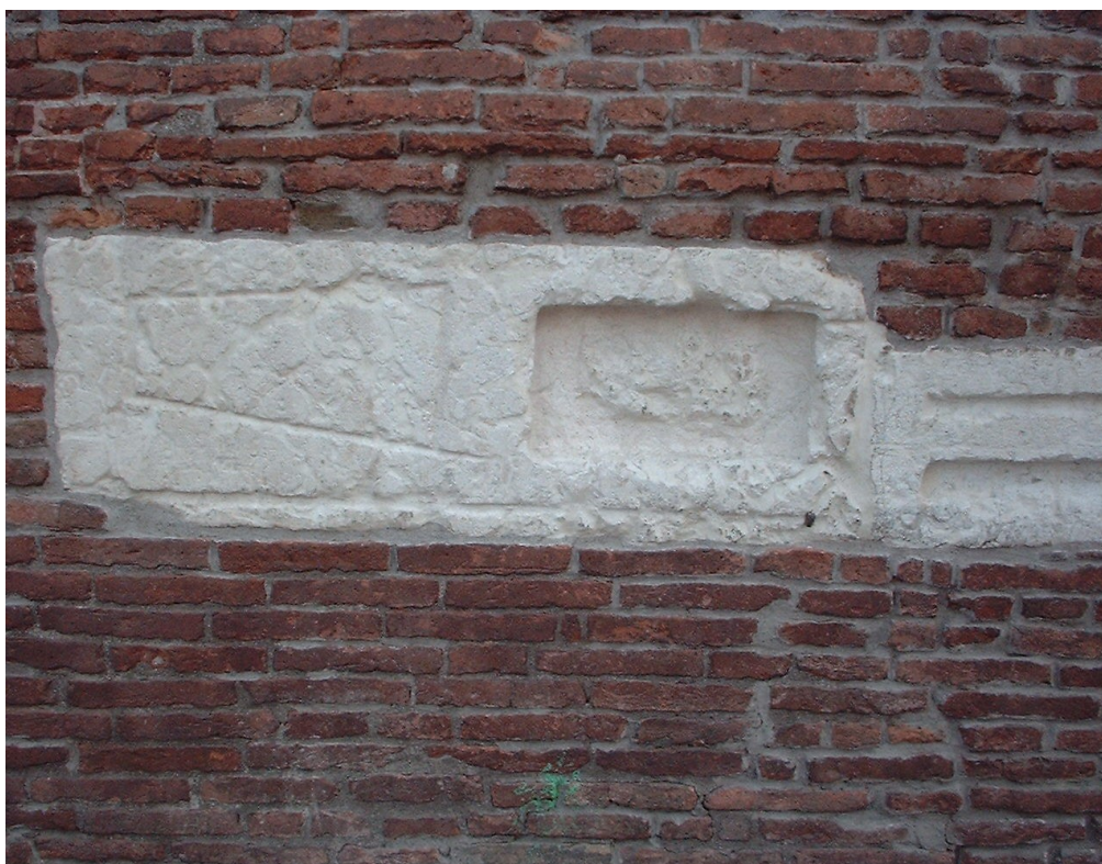
Fig. 18. Forma per la realizzazione di mattoni e modulus per la realizzazione di coppi sul palazzo comunale, Bologna.
