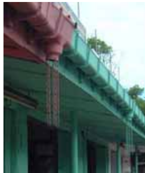
Figura 128 Grondaie in plastica.
