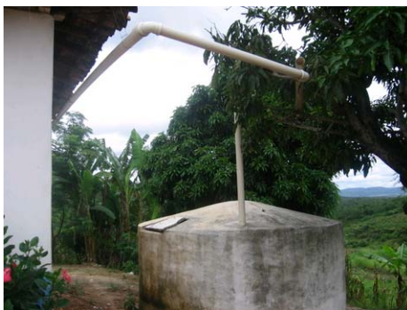
Figura 330 Cisterna ultimata con la tubatura collegata alla grondaia. Vale do Jequitinhonha.
