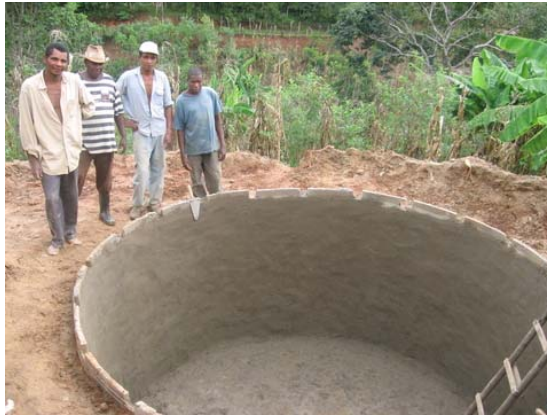
Figura 328 La cisterna dopo il rivestimento interno. Vale do Jequitinhonha.
