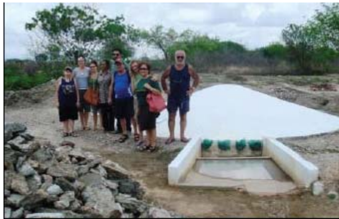
Figura 355 Cisterna caldação. Semi Arido brasileiro. IRPAA.
