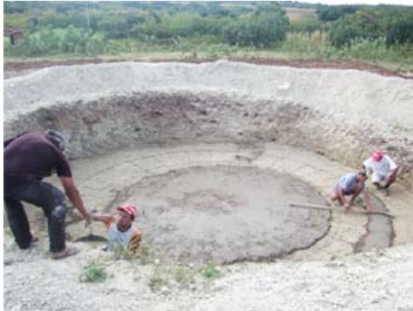
Figura 358 Scavo per la realizzazione della Cisterna Calçada. Semi Arido brasiliano. IRPAA
