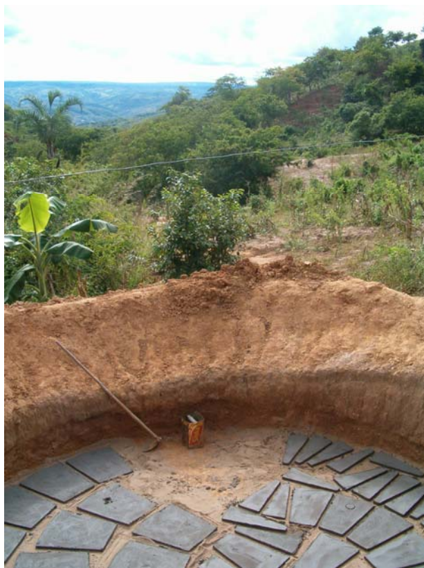
Figura 320 Lo scavo con le placche per il fondo della cisterna. Vale do Jequitinhonha.
