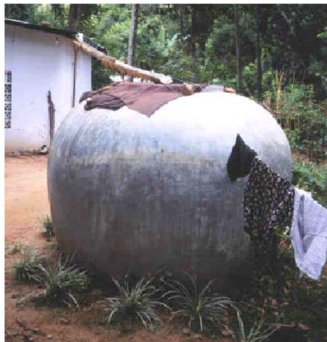
Figura 119 Serbatoio "a zucca" per la raccolta dell'acqua piovana, Sri Lanka. Practical Action
