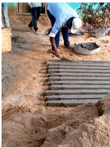
Figura 325 La produzione delle travi per la copertura (con armatura). Vale do Jequitinhonha.
