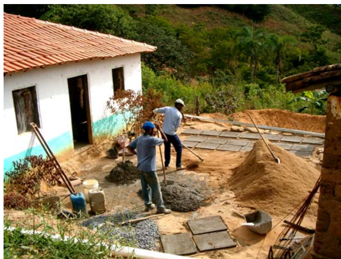
Figura 318 Realizzazione della cisterna. Vale do Jequitinhonha.
