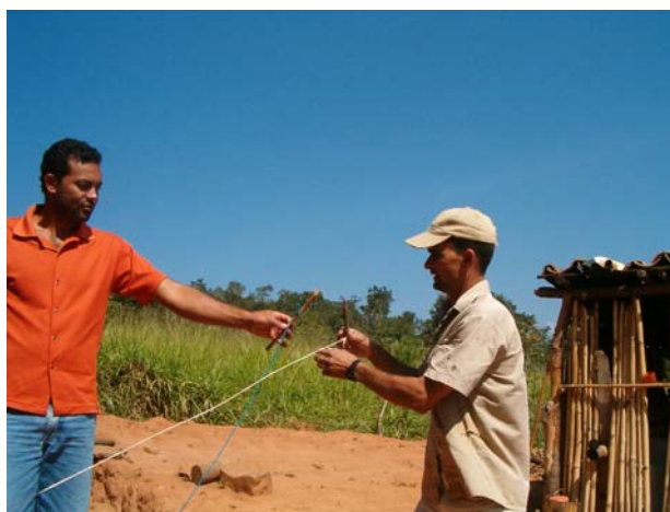
Figura 319 Identificazione dell'area dove fare lo scavo con una fune di 2 m. Vale do Jequitinhonha
