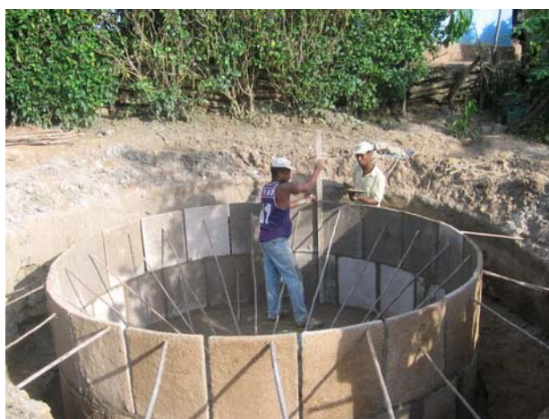
Figura 327 Posizionamento delle placche della parete. Vale do Jequitinhonha.
