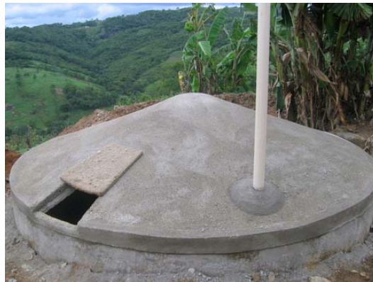
Figura 329 Cisterna con la botola di controllo. Vale do Jequitinhonha.
