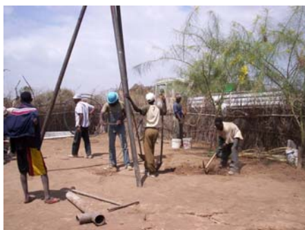
Figura 98 Perforazione con metodo "jetting". Somalia.
