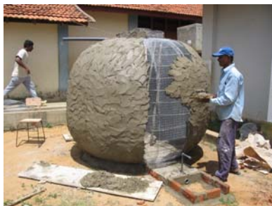
Figura 121 Costruzione del serbatoio per la raccolta dell'acqua piovana. Sri Lanka.
