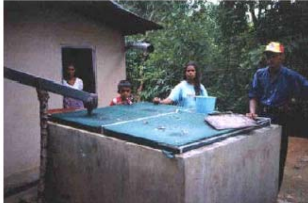
Figura 118 Cisterna per la raccolta dell'acqua piovana, Sri Lanka. Rain Water Harvesting.
