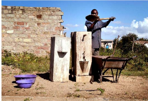
Figura 144 Manutenzione di un filtro a sabbia. BioSandFilter.
