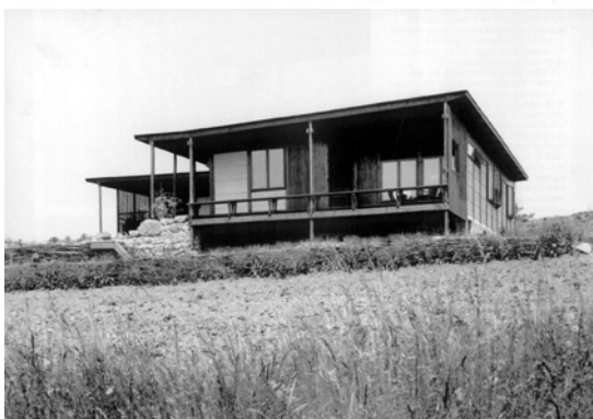
Figura 10. Max Bill, Casa Villinger a Bremgarten, 1942.(demolita nel 1978)
