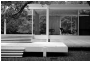
Figura 4. Mies van der Rohe, Casa Farnsworth, 1951.
