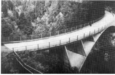
Figura 5. Robert Maillart, Pont du Schwandbach, 1933.
