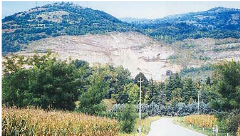
Figura 18. Scarpate soggette ad interventi di inerbimento con idrosemina nell'area di cava di Pian del Cin (Italia) (da: Guida all'Industria Estrattiva e al Riciclaggio. Edizioni PEI. 2002)
