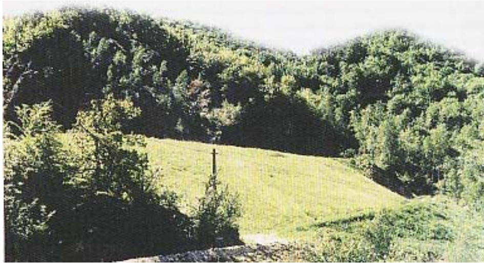
Figura 4. Inserimento paesaggistico di un'area di cava di Valle Vermegnana (da: Guida all'Industria Estrattiva e al Riciclaggio. Edizioni PEI. 2002)
